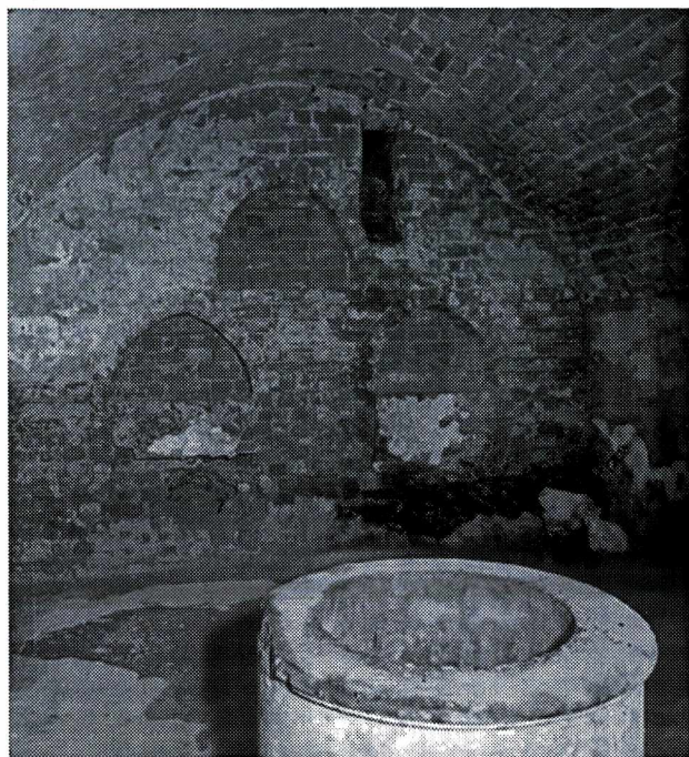
Ryc. 14. Wnętrze piwnicy nr 1 w zachodnim skrzydle budynku klauzury, stan z 2001 r.
