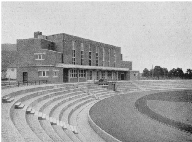
e) Hochschulsportplatz in Freiburg Gymnastikhalle Arch. Herm Alker Place de sport de l'Université à Freiburg i/Br. Sporting ground of University at Freiburg i/Br.
