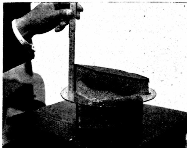
Rys. 17. Zanieczyszczenie piasku w jednym z filtrów w sierpniu 1931 r.
