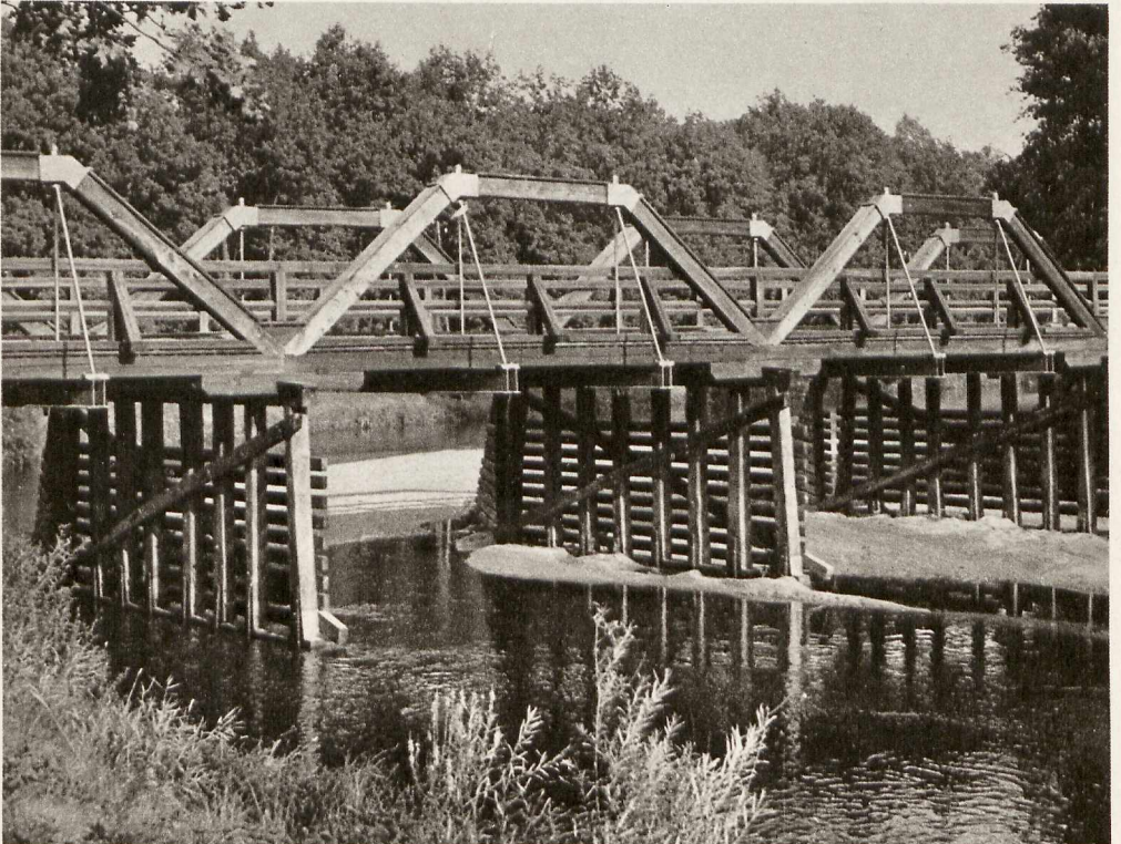
Holzbrücke über den Bober zwischen Sprottau und Sagan
