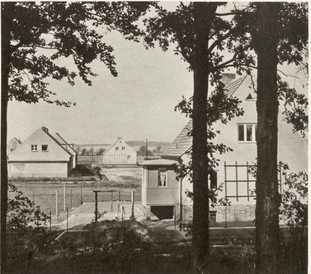
Stadttrandsiedlung in Bunzlau
