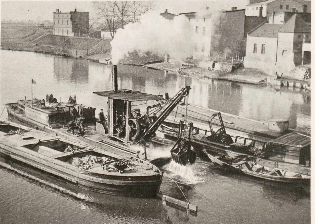
Baggerarbeiten auf der Oder in Oppeln
