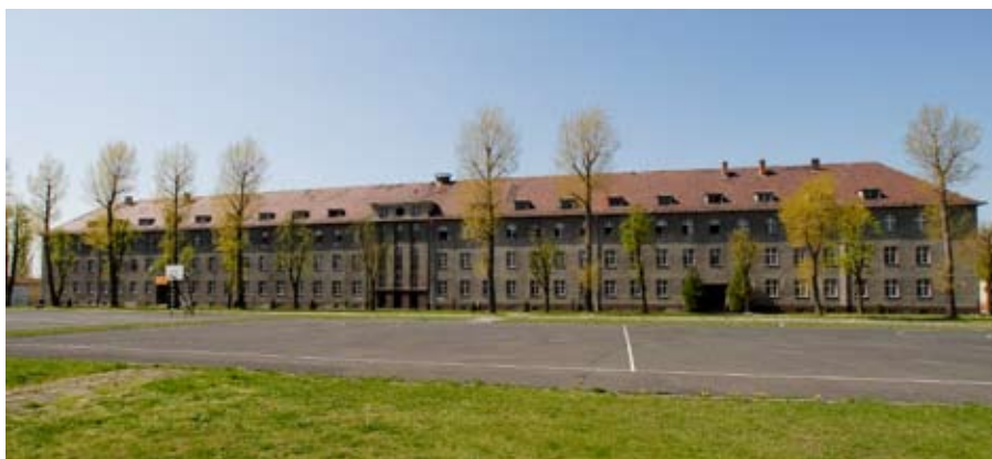
Budynek, w którym rozpocznie się remont
