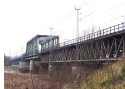
Graniczny most kolejowy przez Odrę w Świecku
