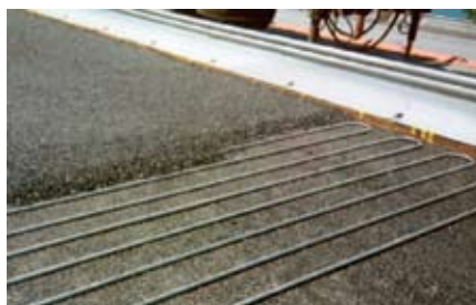
Rys. 5. Układanie rur grzewczo-chłodniczych pod nawierzchnią bitumiczną na izolacji podkładu betonowego drogi nr A-8 na moście w Därligen [1,3].
