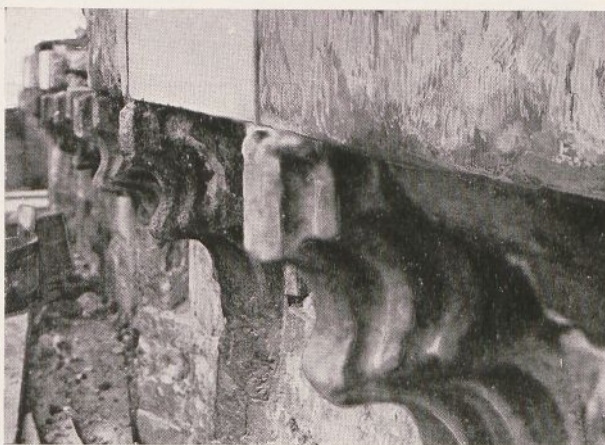
Fig. 138. Kraków. Część gzymsu wieży ratuszowej.
