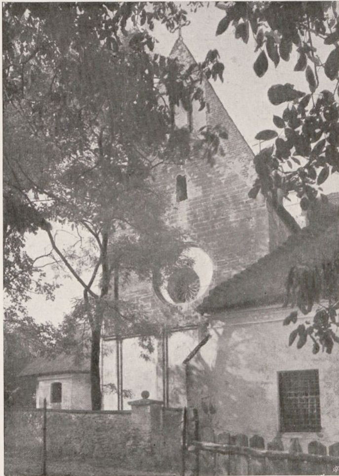
Fig. 37. Koprzywnica. Wschodnia ściana prezbiterjum.
