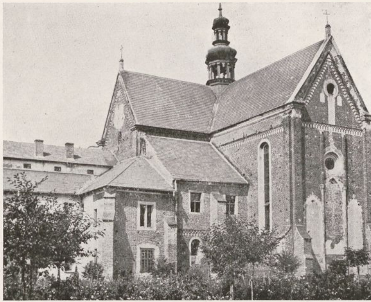
Fig. 71. Mogiła. Kościół cysterski św. Wacława z połowy XIII w. Prezbiterjum i część budowli klasztornych.
