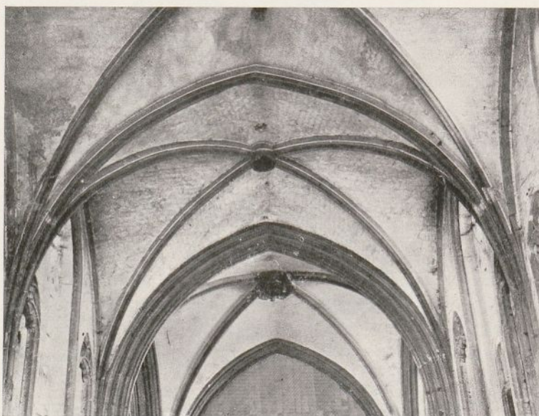
Fig. 141. Kraków. Sklepienie głównej nawy kościoła katedralnego.
