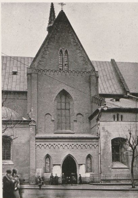
Fig. 66. Kraków. Kościół św. Franciszka. Widok od ul. Brackiej na nawę krzyżową (z poł. XIII w.).
