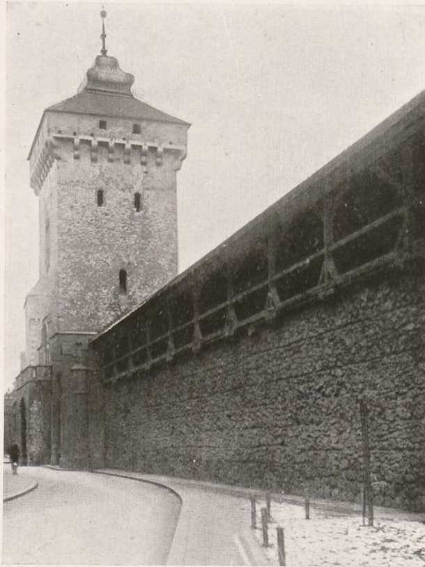
Fig. 127. Kraków. Fragment murów obronnych z Bramą Florjańską od strony miasta.
