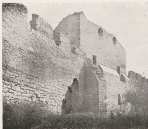
Fig. 107. Szydłów. Mury obronne przy zachodniej ścianie zamku, której restaurację rozpoczęto w roku 1927.
