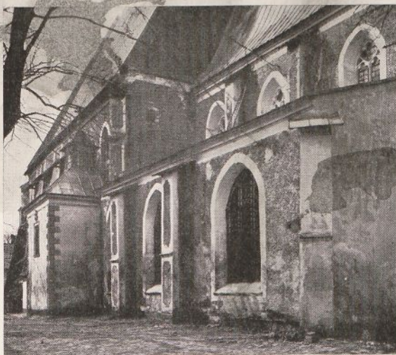
Fig. 162. Olkusz. Kościół św. Andrzeja z zewnątrz od strony pd. wschodu.
