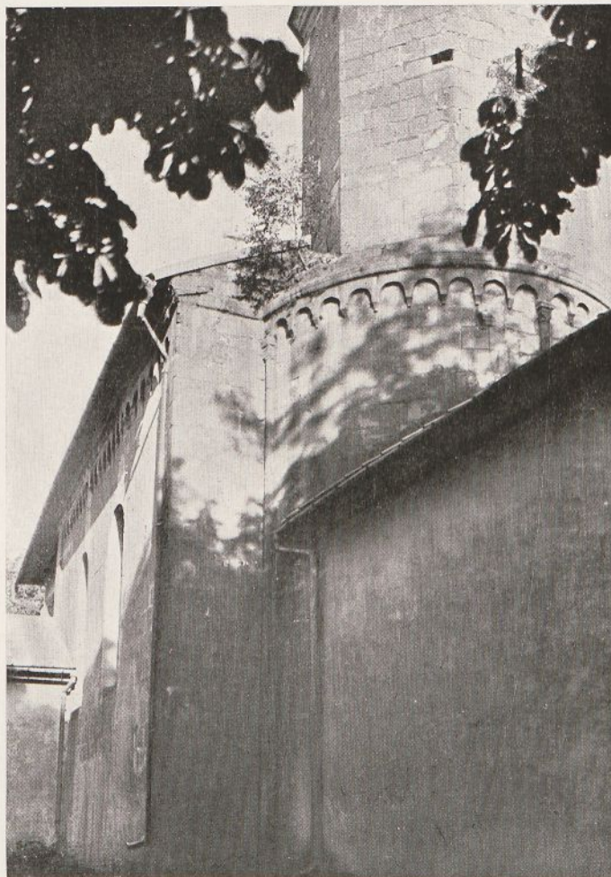
Fig. 16. Prandocin. Widok kościoła od strony zachodniej.
