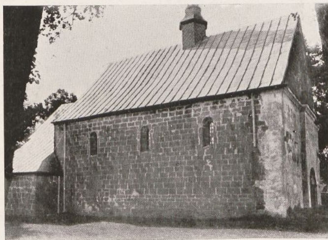
Fig. 19. Tarczek. Kościół św. Idziego (XII w.) od strony północno-zachodniej.
