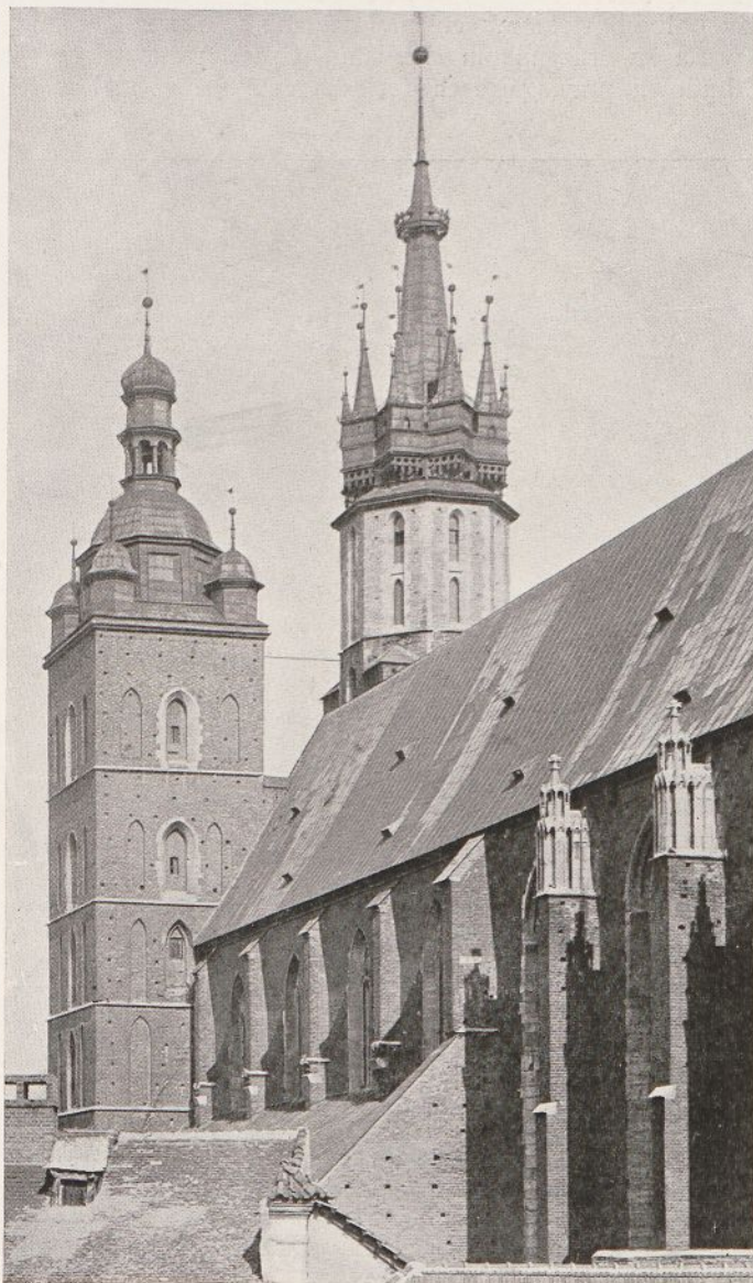
Fig. 147. Kraków. Kościół N. P. Marji, widziany z góry, od strony Małego Rynku.
