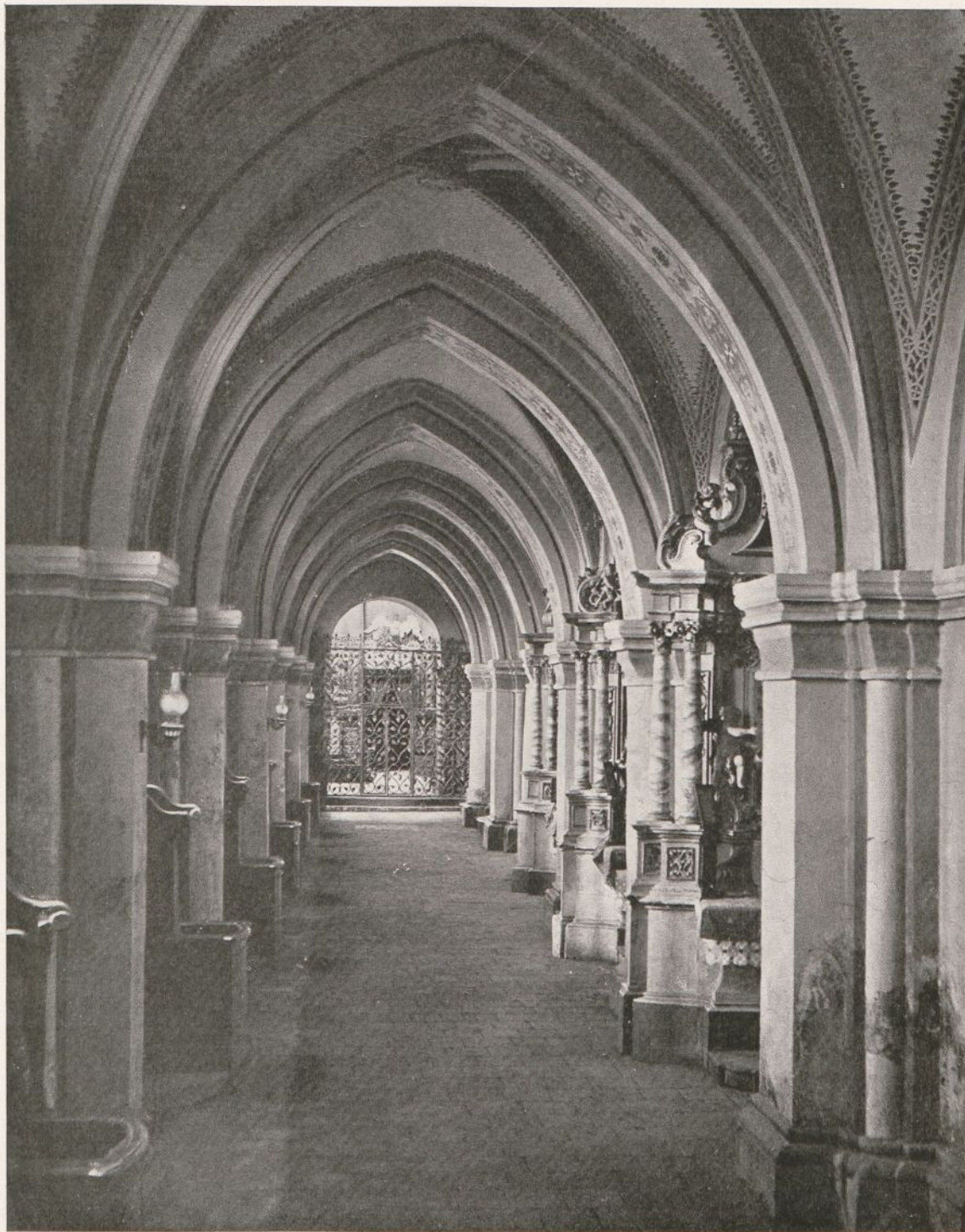
Fig. 75. Mogiła. Północna nawa boczna przed ostatnią restauracją.
