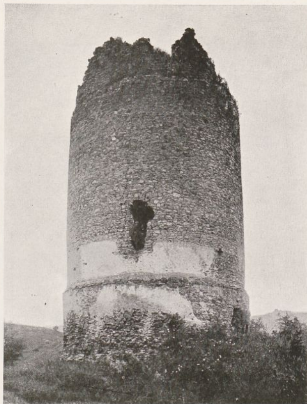
Fig. 113. Czchów. Ruina baszty zamkowej.
