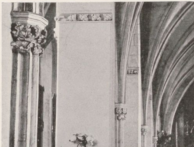
Fig. 158. Sandomierz. Część sklepień kościoła kolegiackiego, obecnie katedry, p. w. N. P. Marji
