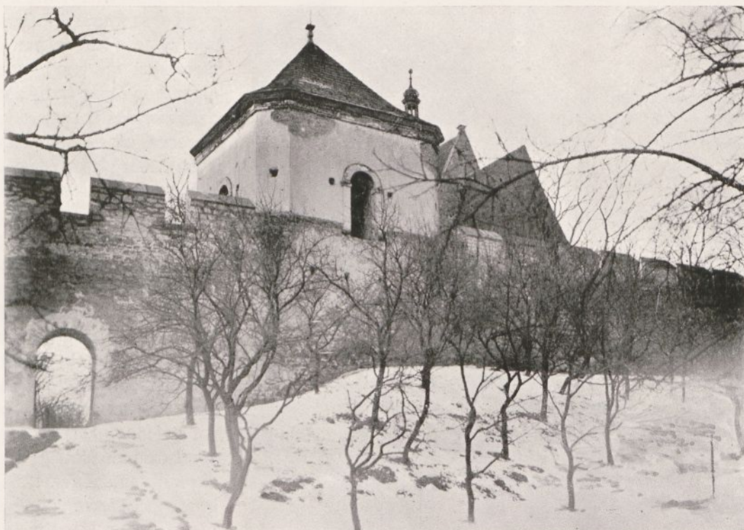
Fig. 130. Szydłów. Obronne mury obok kościoła. Widok zewnątrz miasta.
