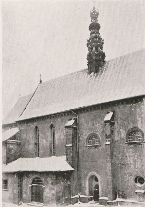
Fig. 96. Stary Sącz. Kościół Klarysek p. w. ś. Trójcy. Pocz. XIV w. Północna ściana nawy i oratorium.
