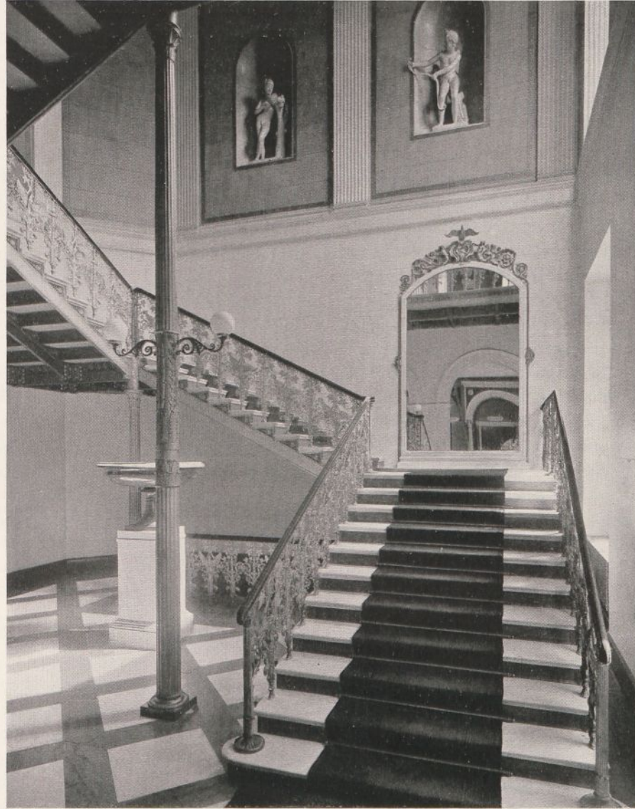
179. Das Treppenhaus. Aufnahme 1921
