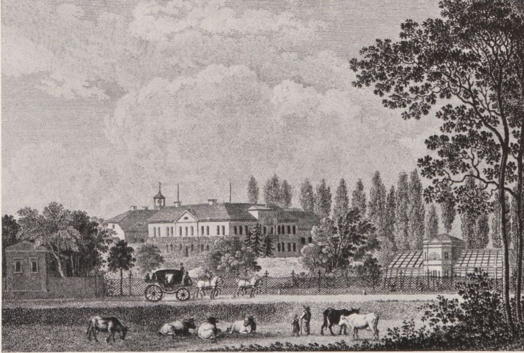
12. Schloß Glienicke vor dem Umbau durch Schinkel. Stich von Jury nach Mauch, 1824
