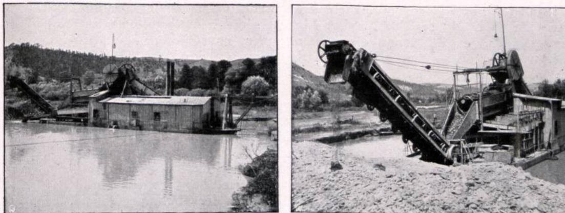
Abbild. 59 u. 60. Dampfbagger in einer Goldseife des serbischen Pek-Tales. (Nach Fhrn. von Unterrichter.)
