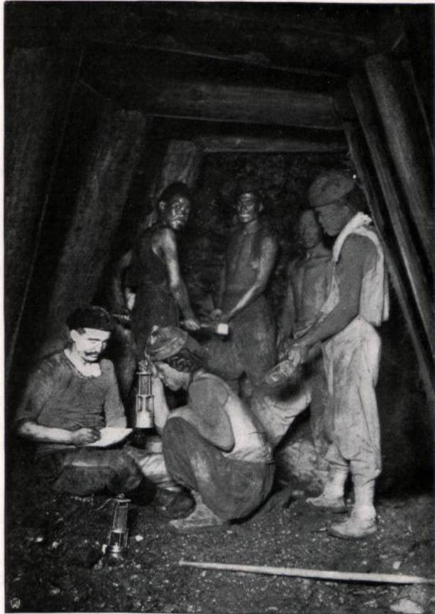
Abbildung 44. Hölzerner Streckenausbau. Fangtse Steinkohlenbergwerk der Schantung-Bergbaugesellschaft, Berlin.
