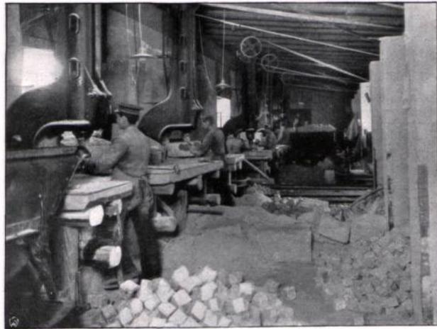
Abbildung 74. Eine Kunathsche Spalterei mit elektrisch angetriebenen Spaltmaschinen.
