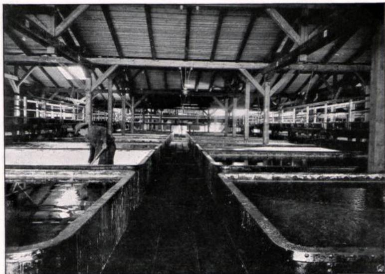
Abbildung 102. Kristallisierkästen der Achenbach-Fabrik.
