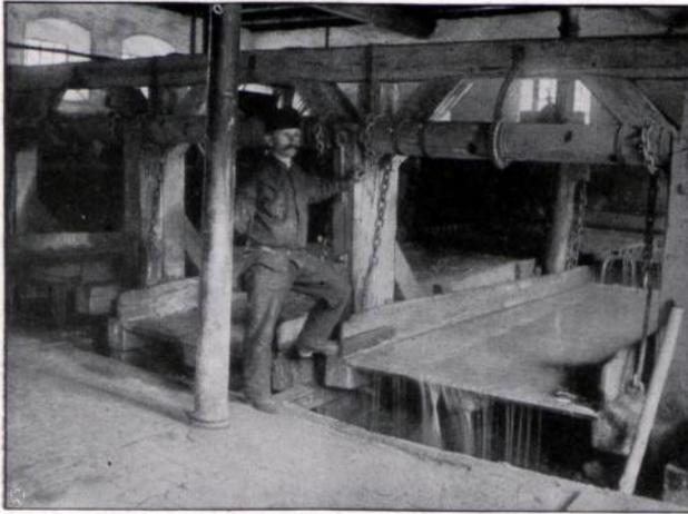
Abbildung 25. Ein alter Freiburger Stoßherd (Langstoßherd) auf der Grube Alte Hoffnung Gottes. (Nach K. Reimann.)
