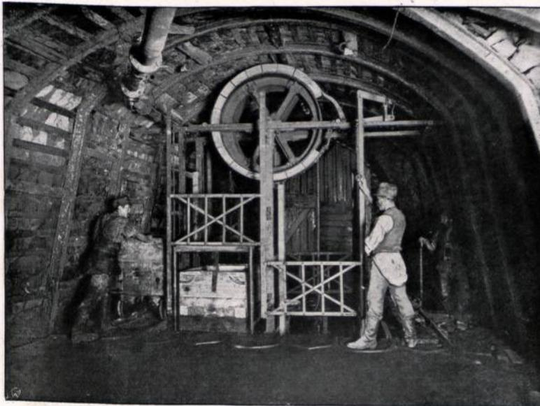
Abbildung 19. Saigerer Bremschacht. (Nach einer Aufnahme von H. Börner. Verlag von Craz & Gerlach, Freiberg i. S.)
