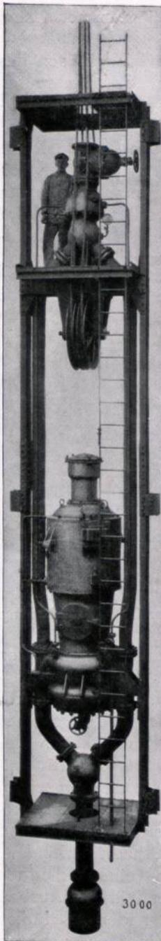
Abbildung 37. Hochdruckzentrifugalpumpe zum Schachtabteufen.
