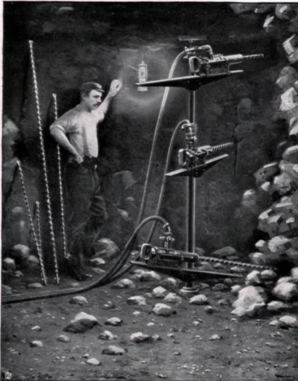
Abbildung 57. Preßluftbohrhämmer auf Führungsschlitten.
