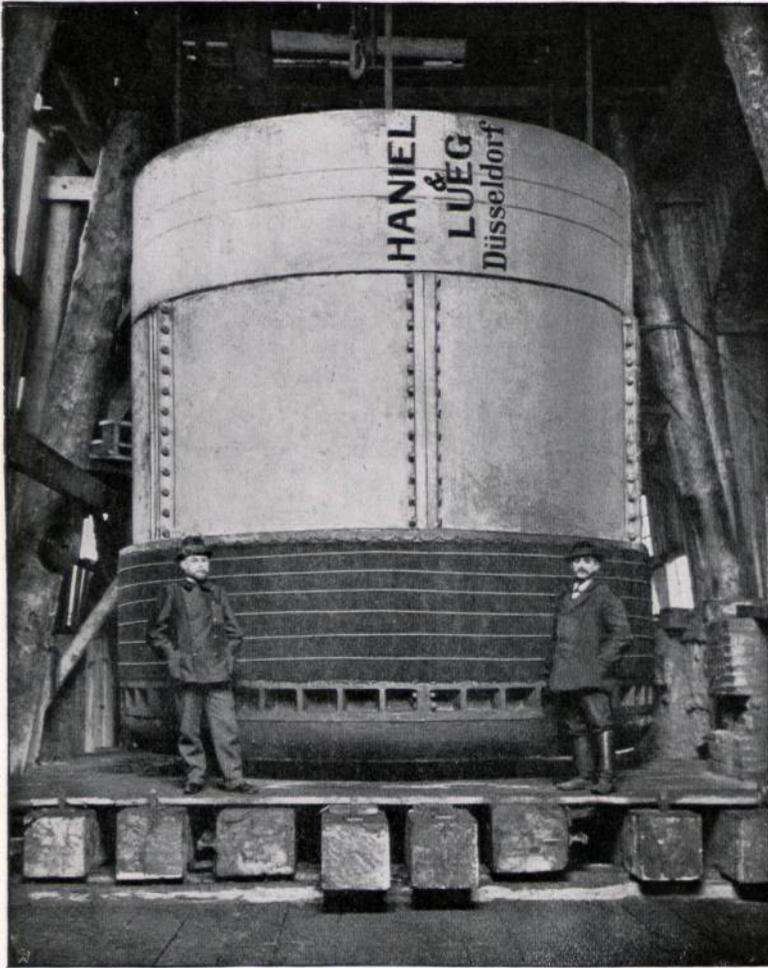
Abbildung 40. Moosbüchse für Schachtabteufen nach Kind-Chaudron.
