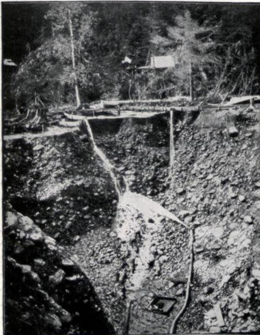
Abbildung 56. Hydraulische Seifenarbeit in Alaska.
