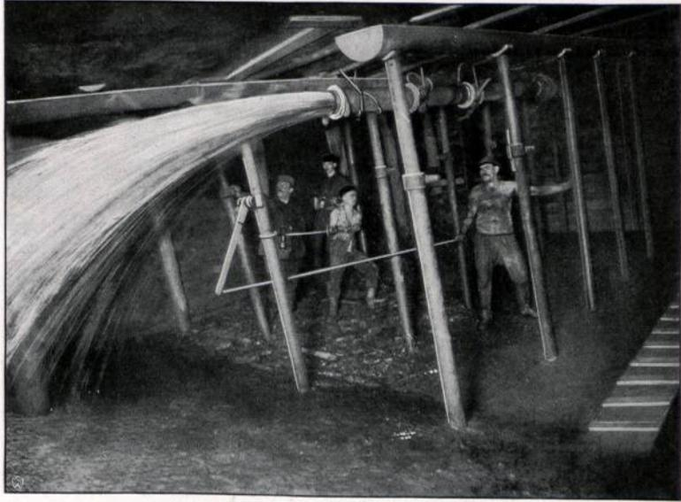
Abbildung 43. Spülversatz in einem mit eisernen Stempeln verbauten Zwickauer Steinkohlenabbau.
