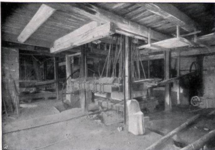
Abbildung 71. Steinsägegatter. Steinsägewerk Rottwerndorf. Firma Fleck & Illmert. (Nach einer Phot. von K. Reimann in Freiberg.)
