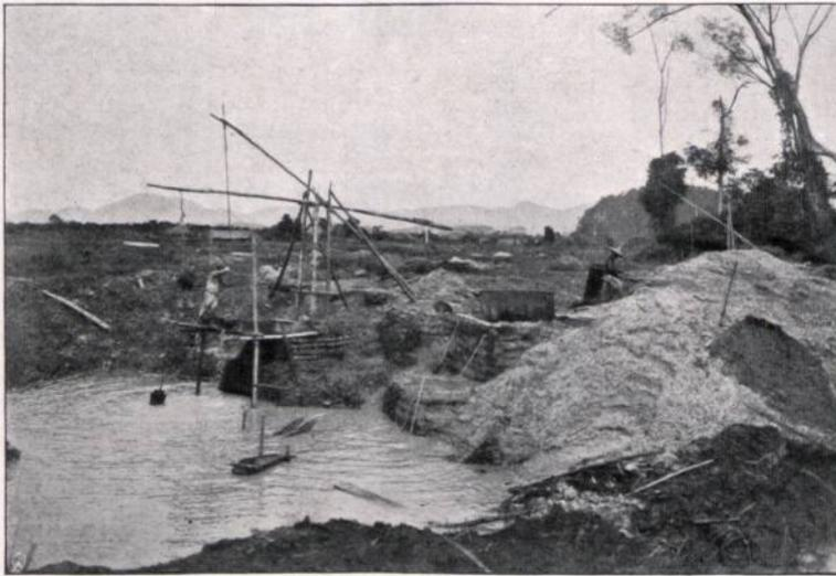
Abbildung 16. Eine Zinnseife nach alter chinesischer Art im Distrikt Kinta auf Malakka. Man sieht die Aufbereitung in hölzernen Gerinnen (Schleusen) mittels aufgeschütteten Wassers. (Nach einer Photographie von W. Wolff, 1908.)
