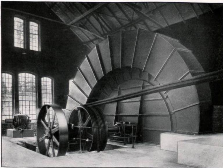
Abbildung 48. Großer Grubenventilator der Zeche Radbod in Westfalen.
