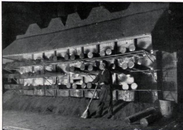
Abbildung 43. Zinkdestillationsofen der Zinkhütte Birkengang zu Stolberg. (Mit Genehmigung des Herrn Hütten Direktors Jurejka zu Stolberg, Rhld.)
