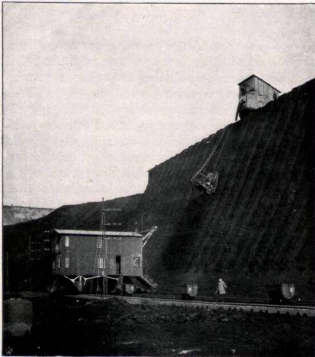
Abbildung 22. Maschinelle Braunkohlegewinnung. (Kohlenhauer von Muth-Schmidt.) Grube Grefrath bei Köln.
