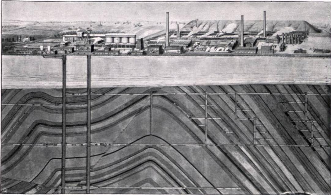
Abbildung 33. Querschnitt durch die Steinkohlenzeche Shamrock III/IV bei Herne in Westfalen.
