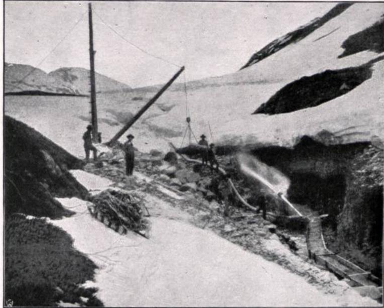
Abbildung 57. Hydraulische Seifenarbeit am Rande des ewigen Schnees in Alaska. (Nach Ch. W. Wright.)
