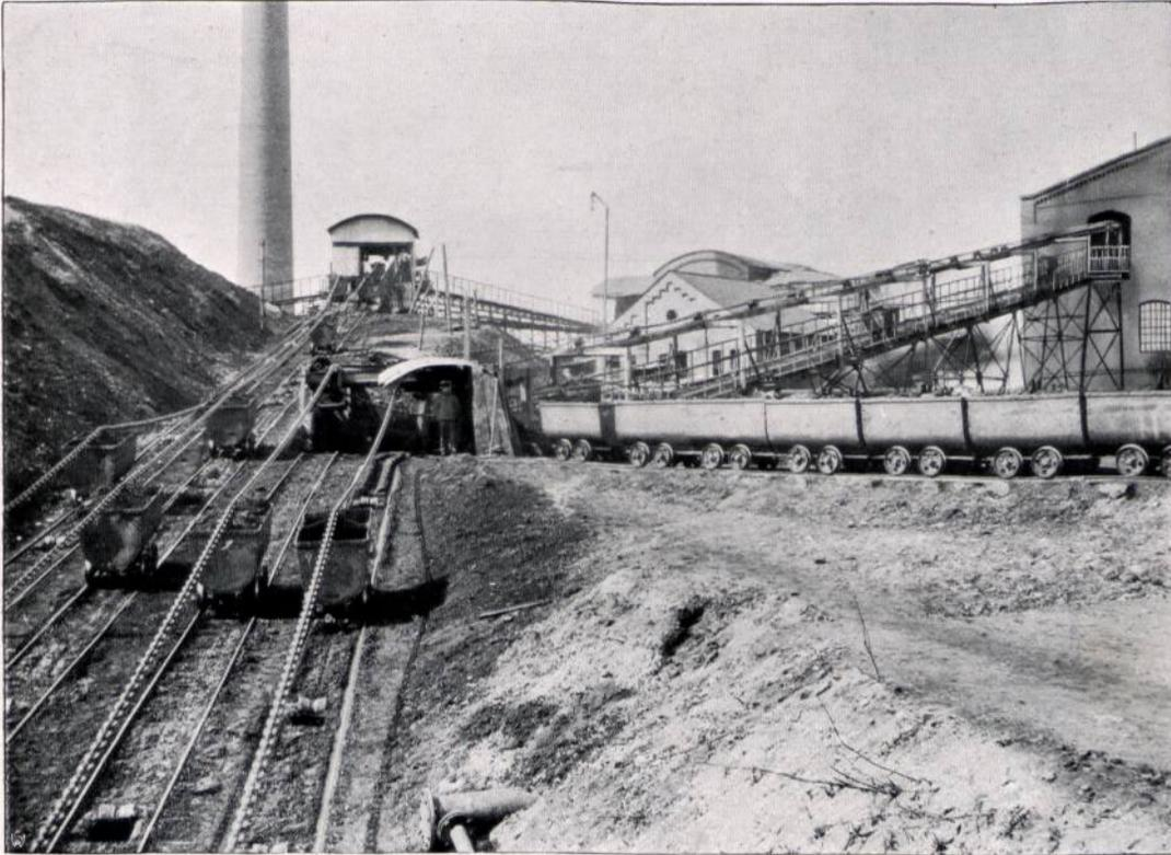
Abbildung 28. Kettenbahnen, aus einem Braunkohlentagebau zu den Brikettfabriken führend.
