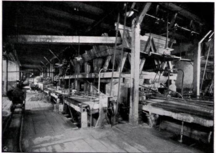
Abbildung 26. Blick in die Zentralwäsche der Grube Himmelfahrt bei Freiberg. Ganz hinten links Setzmaschinen. Im Vordergrund Steinsche Planherde. Oben Spitzkästen. (Nach einer Photogr. von K. Reimann, Freiberg.)
