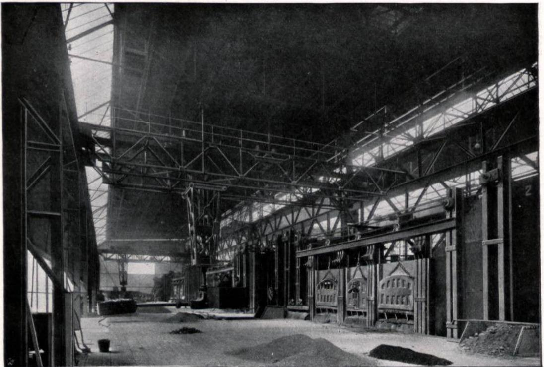
Abbildung 27. Westfälische Stahlwerke in Bochum: Blick auf die Beschickungsbühne eines Martinofens.
