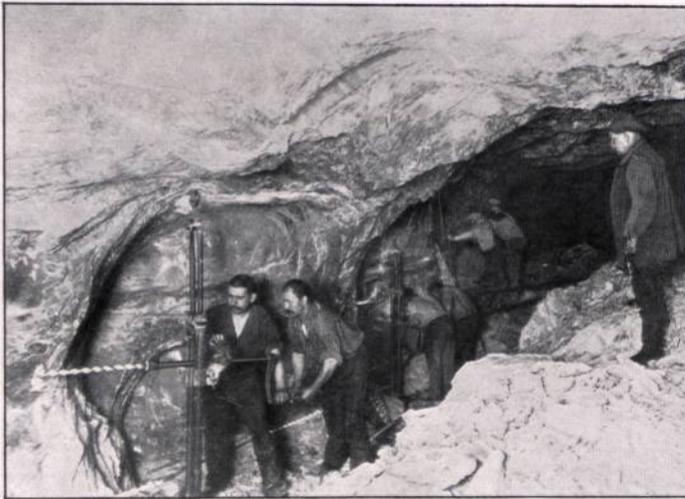
Abbildung 97. Firstenbau im Kainit von Leopoldshall mit Handbohrmaschine.
