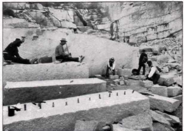
Abbildung 73. Das Abspalten langer Werkstücke mittelst Keilarbeit in den C. G. Kunathschen Brüchen.
