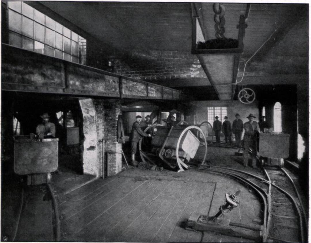
Abbildung 29. Kohlenverteilungsboden über dem Naßdiensthaus einer Braunkohlenbrikettfabrik.
