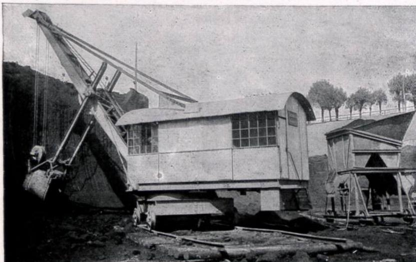
Abbildung 24. Maschinelle Braunkohlengewinnung durch Löffelbagger bei den Rositzer Braunkohlenbergwerken.
