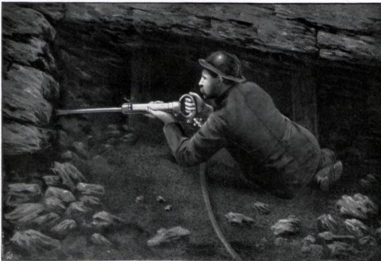
Abbildung 59. Preßluftbohrhammer als Schrämwerkzeug benutzt.
