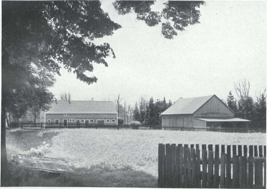
Bild 7. Neubaustelle in Dalbersdorf, Kreis Groß Wartenberg, nach Typ „E 1“
