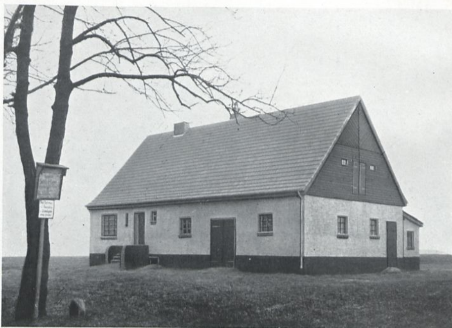
Bild 13. Neubau eines Wohn- und Stallgebäudes nach Typ „G 8“ in Klein Sürding, Kreis Breslau
