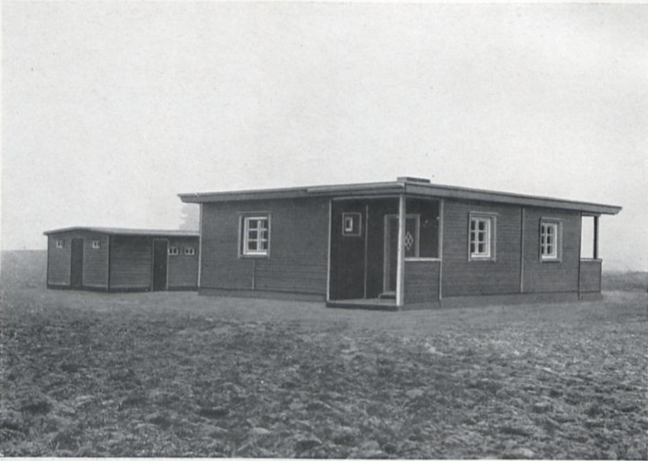
Bild 29. Doppelwohnhaus in kombinierter Maffiv- und Holzbauweise für Landarbeiter in Krampitz, Kreis Neumarkt
