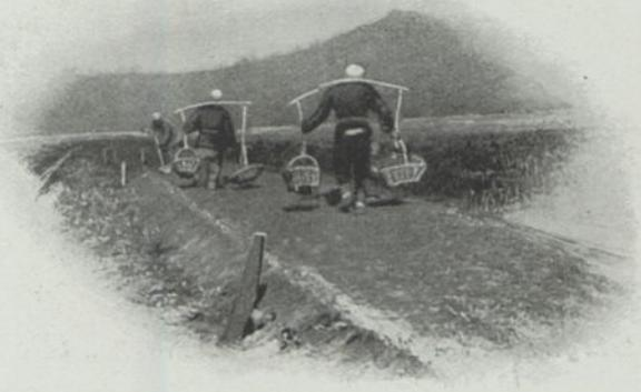
*Transport von Erde in Körben durch Chinesen bei dem Bau der Tihoteobahn am Japanischen Meer*
