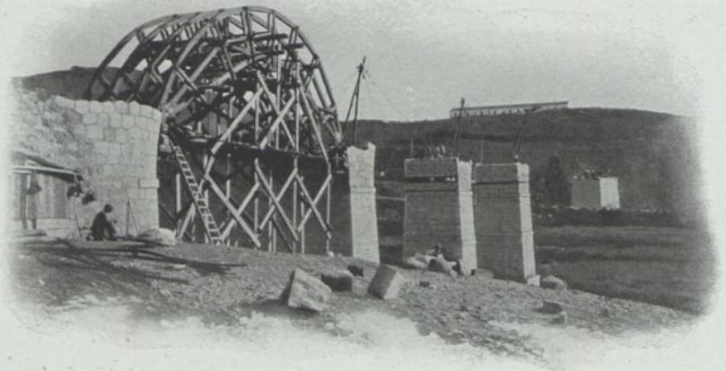
Montage eines Lehrgerüsts bei dem Bau der Canaleo-Brücke in Südspanien
