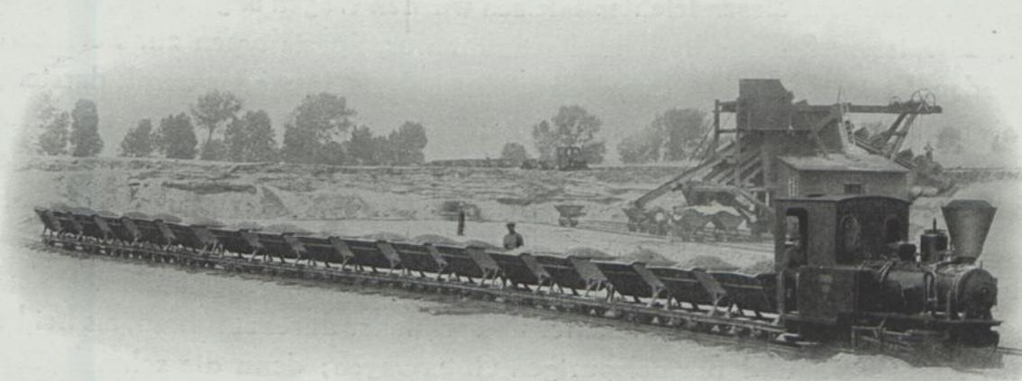
*Feldbahn mit Lokomotivbetrieb zum Kiestransport*
