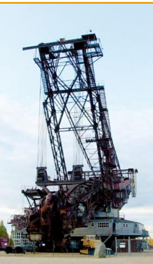
Koparka SchRS 1200, prod. NRD, w muzeum górniczym w Hagenwerder-Goerlitz (kilkanaście km od KWB Turów). Koparki tego typu do dziś służą w kopalni Turów
