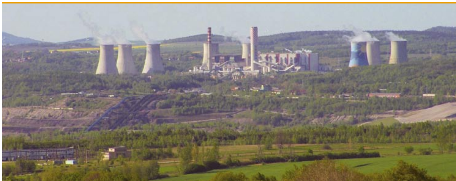
Elektrownia Turów oraz północny fragment odkrywki kopalni Turów (z widocznymi taśmociągami transportującymi urobek do sortowni, tzw. pochylnia). Widok z Bogatyni
