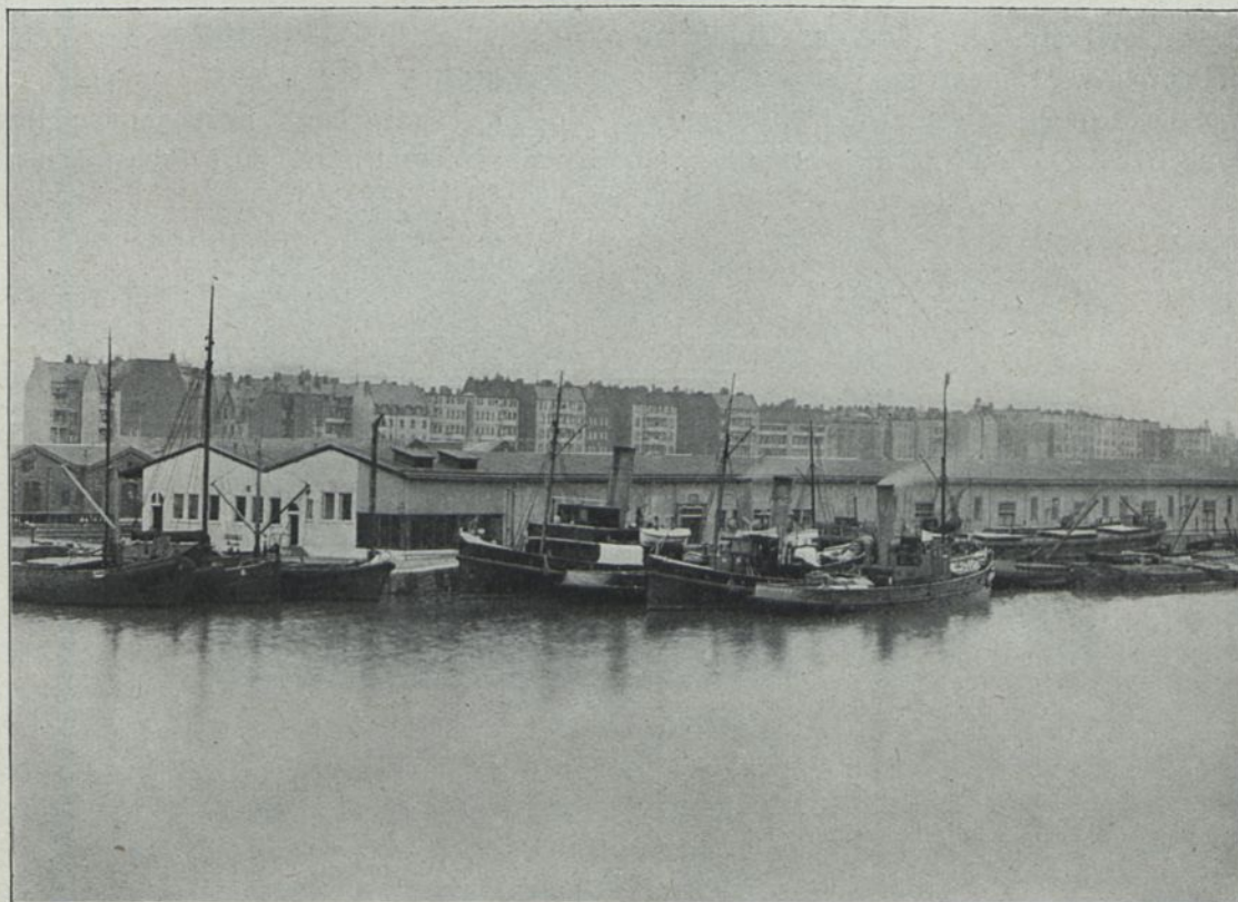
Fig. 5 Ansicht von der Hafenseite
