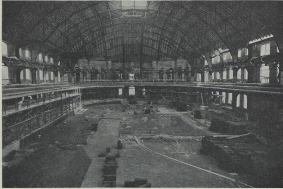
Fig. 1 Verlegen der Korksteinplatten
