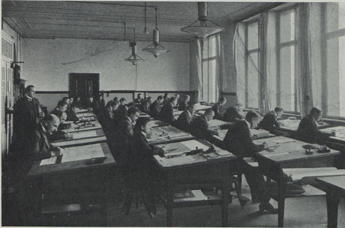
Fig. 4 Konstruktionsbureau der Abteilung: Kältemaschinen
