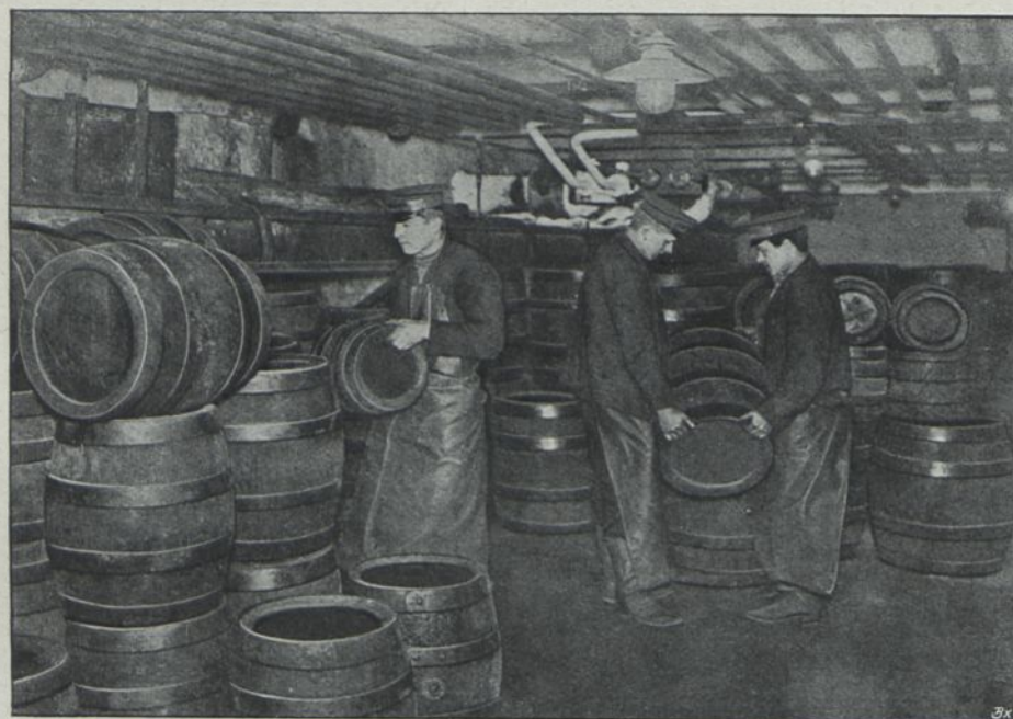
Fig. 18 Kühlraum für Bier
