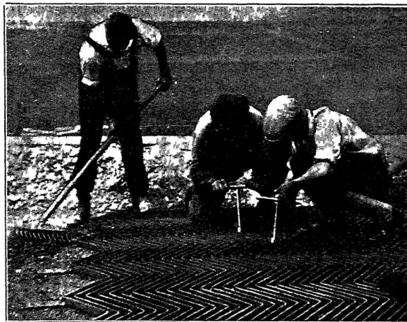
Ryc. 2. Widok układania rusztów i ich łączenia.
