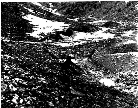
Ryc. 2. Zapora na potoku Jaworzynie, dopływie Bystrej. Zdjęcie wykonane w r. 1901.
