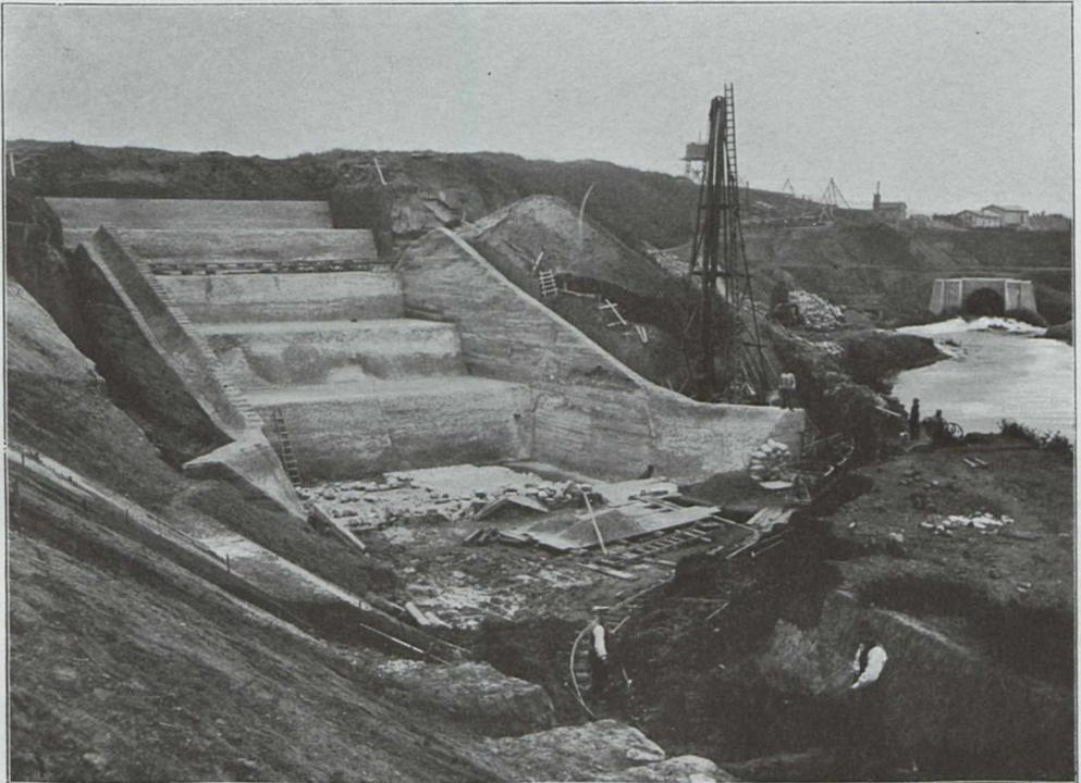
Fig. 7. Umflutkanal der Radaune mit massiver Überfallschwelle (während des Baues).
