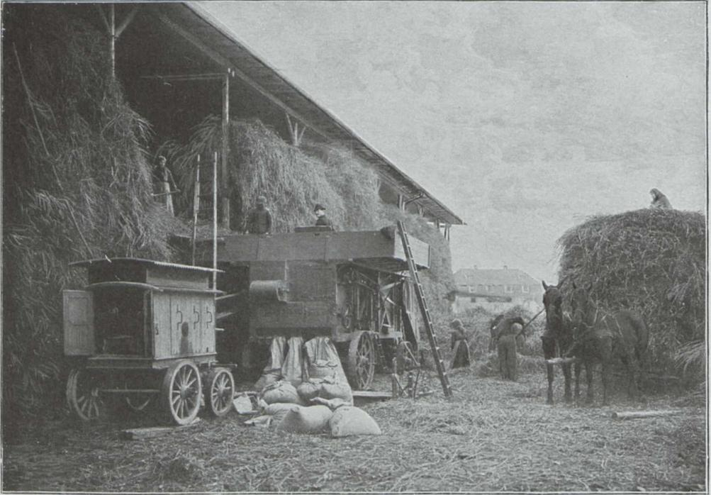
Fig. 21. Dreschmaschine mit fahrbarem Elektromotor.
