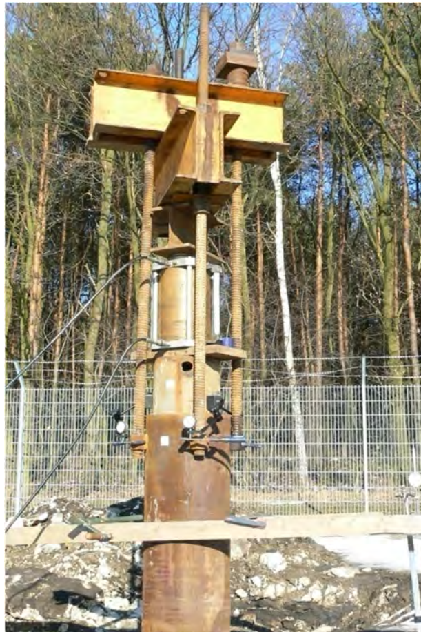
Rys. 4.10. Zdjęcie stanowiska badawczego przy zagłębieniu pala na 6,5 m
