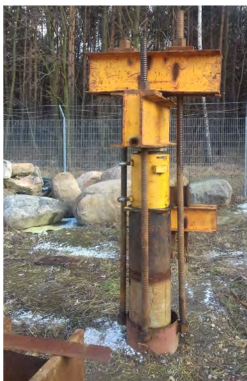
Rys.4.16. Stanowisko do przeprowadzenia testów samorzównoważonych podczas zagłębienia pala na głębokości 8,0 m
