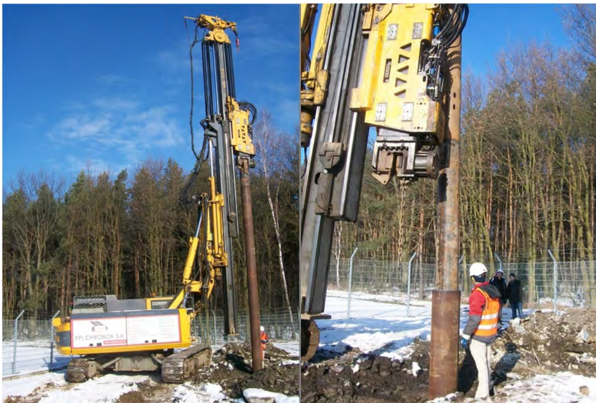
Rys. 4.9. Instalacja pala w gruncie
