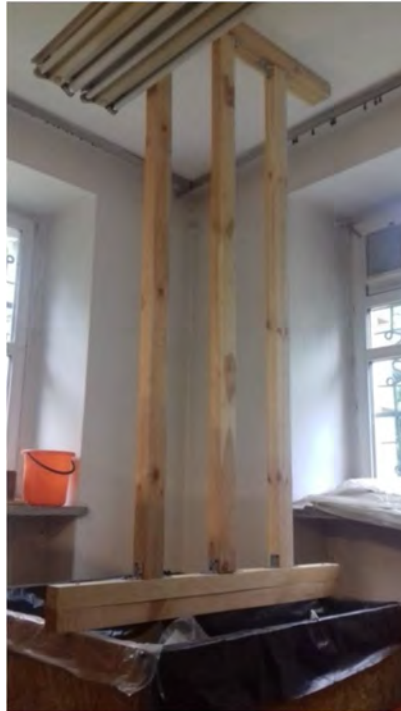
Rys. 5.15. Konstrukcja oporowa zapewniająca odpowiednie rozparcie dla siłownika
