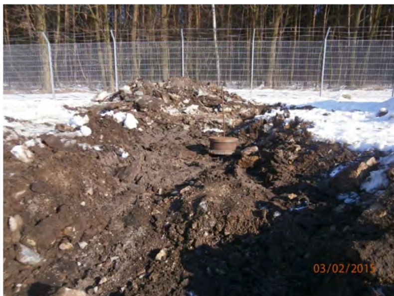
Rys. 4.3. But stalowy umieszczony w miejscu późniejszego wykonania pala
