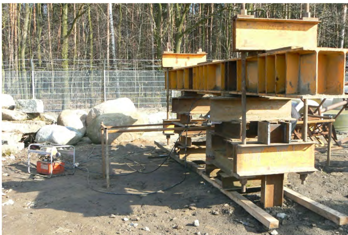
Rys. 4.13. Stanowisko badawcze do przeprowadzenia standardowych próbnych obciążeń statycznych 27.02.2016 r. i 19.03.2016 r.
