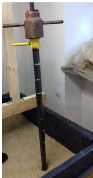
Rys. 5.9. Instalacja pala stalowego za pomocą sondy dynamicznej lekkiej
