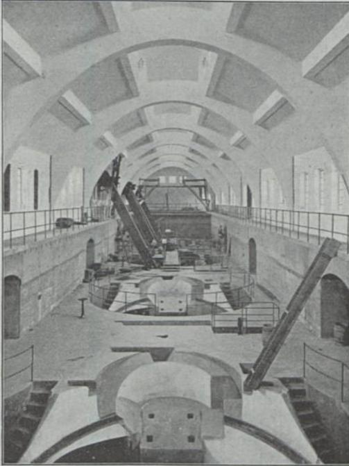
Abb. 108. Reinigungsanlage mit Separatorscheiben Patent Riensch für die Stadt Dresden in Kaditz.
