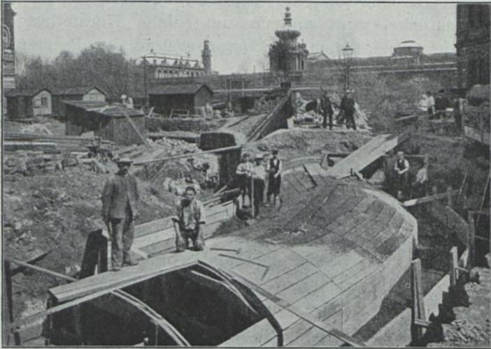
Abb. 26. Die Einschaltungsarbeiten bei der Verlegung des Weißeritzmühlgrabens am Zwinger in Dresden.
