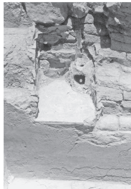
Ryc. 155. Budynek MP 28. Nisza w pomieszczeniu 281. Widok od południa
