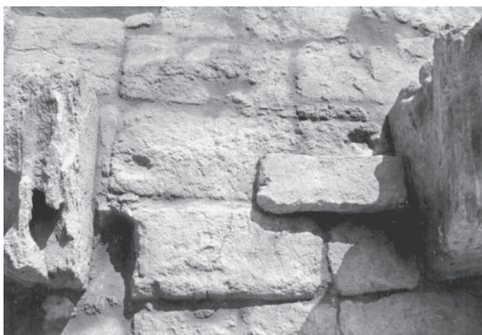
Ryc. 176. Budynek WA 01. Wejście do pomieszczenia 12. Szczegół progu
