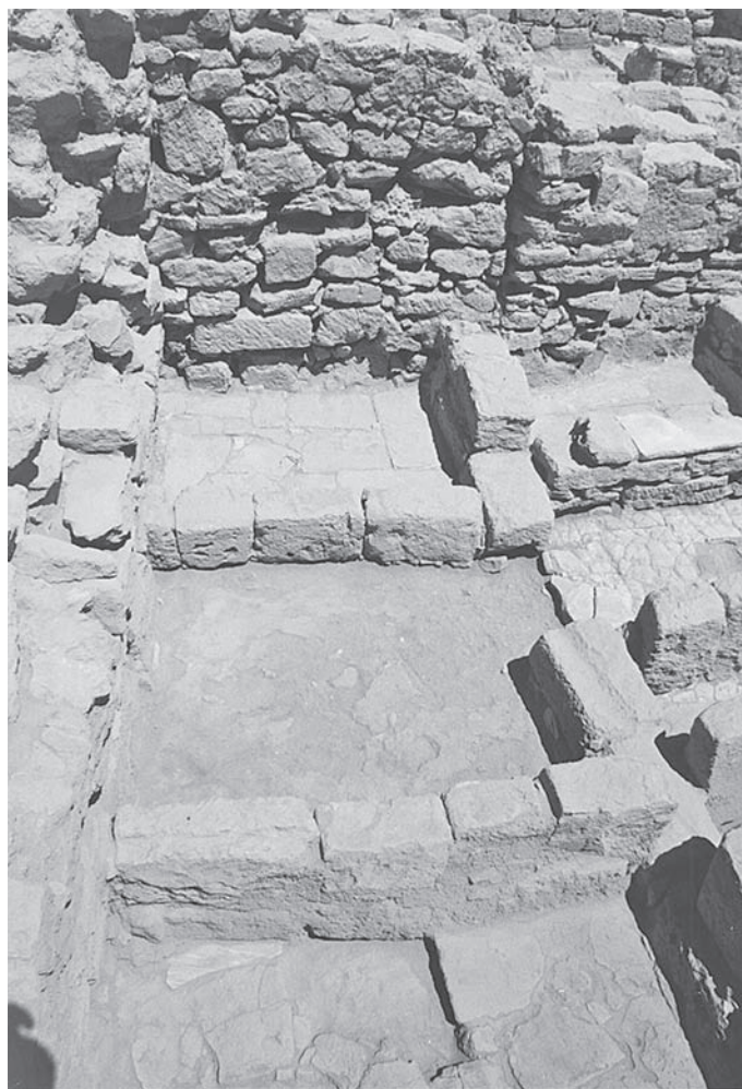
Ryc. 59. Budynek MP 03. Pomieszczenie 31. Widok od zachodu
