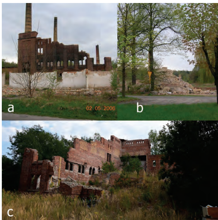
Ryc. 7. Infrastruktura zakładu Dachówczarnia II: a – stan budynku technicznego w roku 2006, widok od ul. Głowackiego; b – resztkowe ruiny budynku administracji w roku 2006; c – stan budynku technicznego od przeciwnej strony w roku 2018 (arch. własne autora) Fig. 7. Dachówczarnia II infrastructure: a – the condition of the technical building in 2006; b – remainings of the administration building in 2006; c – the condition of the technical building from the back side in 2018 (author's archive)
