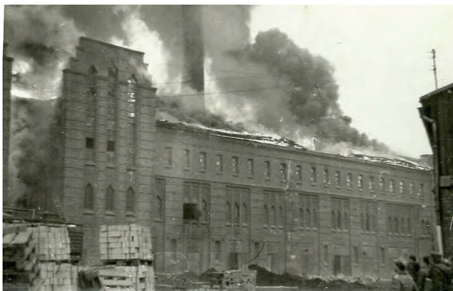
Ryc. 4. Pożar budynku technicznego Dachówczarnia II w latach osiemdziesiątych (www.facebook..., 2018)
