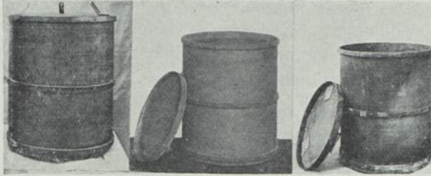
neu before use avant l'usage 5 Monate benutzt used during 5 months en usage pendant 5 mois 1 Jahr lang benutzt used during 1 year en usage pendant 1 année
