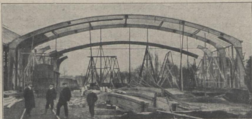
Abb. 296. Aufstellung der Binder der Reichseisenbahnhalle.
