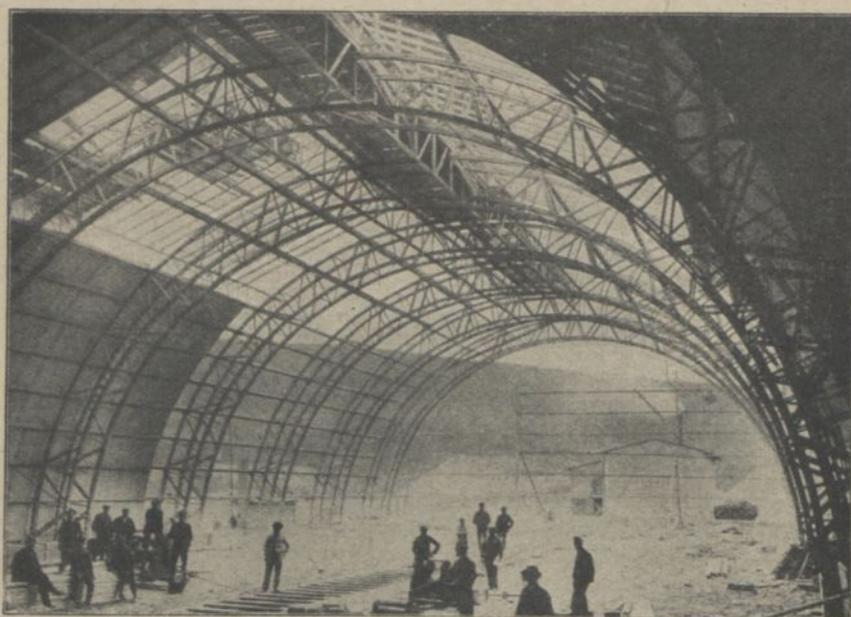
Abb. 267. Salzlagerrhalle während der Ausführung.
