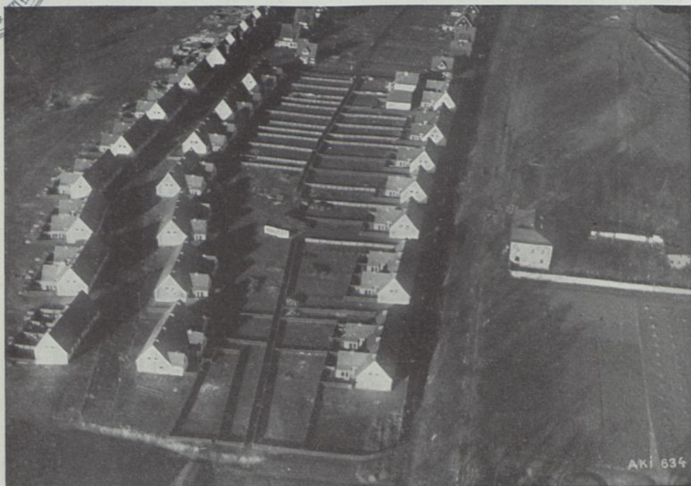
Abb. 3. Oberschlesische Heimstätte: Siedlung Gleiwitz Süd.
