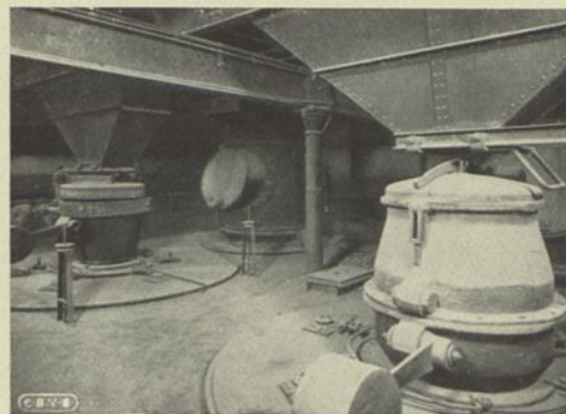
FÜLLVORRICHTUNGEN FÜR DEN ZENTRAL-GENERATOR EINER GASBRENNOFENANLAGE
