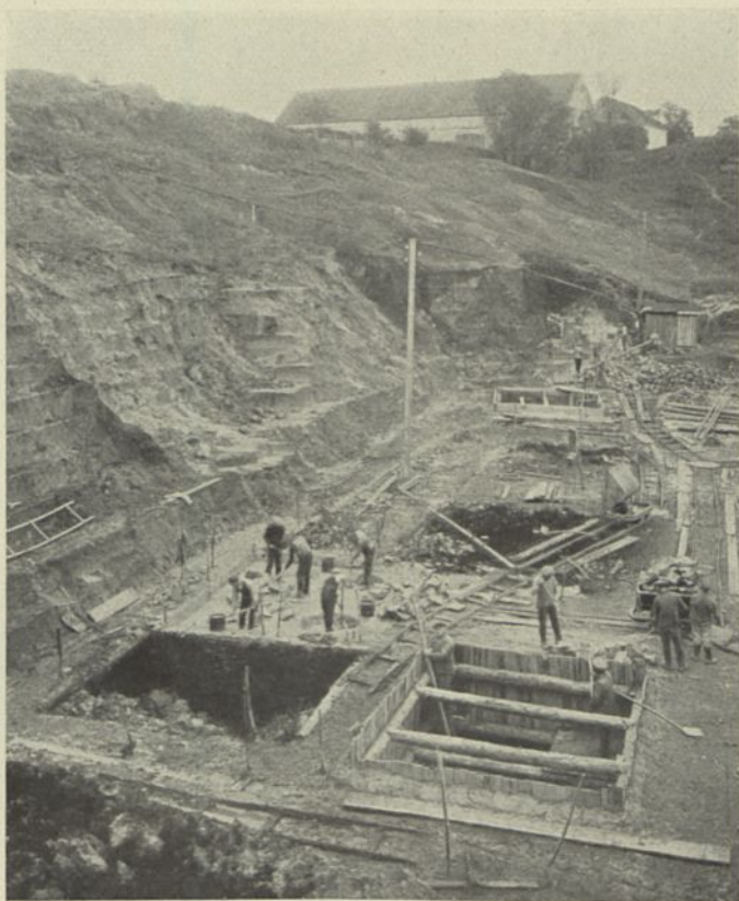
SCHACHTABBAU IN EINER BLAUTONGRUBE
