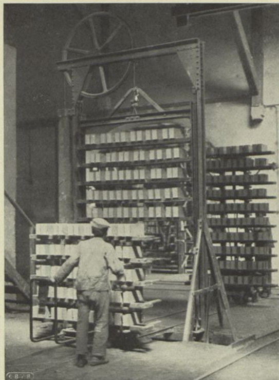
SCHALTWERK FÜR DIE VERTEILUNG DER GEFORMTEN STEINMENGEN AUF DIE ÖFEN
