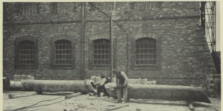
BEHAUEN UND BOHREN MITTELS PRESSLUFT
