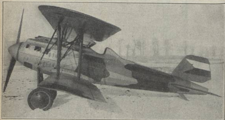
Letov S 7a (1924) KJ 1; E: A. Smolik b = 10,00 m; l = 7,08 m; L = 0,70 t; N = 0,30 t; G = 1,00 t; V = 235 km/h; St = 5,0 km/13'30"; M: Hispano 300 PS-HP-CV; Bst.: H, S, St. Letov, Cs. továrna na Létadla, Letnany
