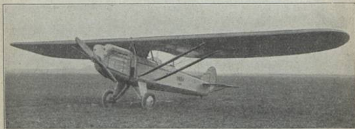
L'avion observation Parasol „BREDA A 7” avec moteur „Asso” 500 CV Construction en acier.
