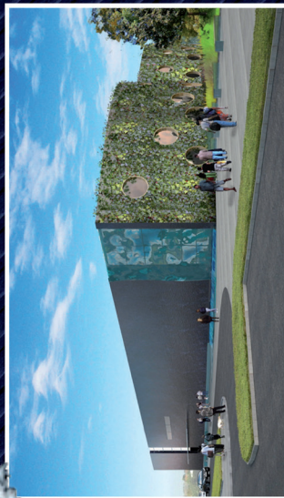
Kryta pływalnia o olimpijskiej wymiarach w III kampusie przy ul. Proszkowskiej 76
