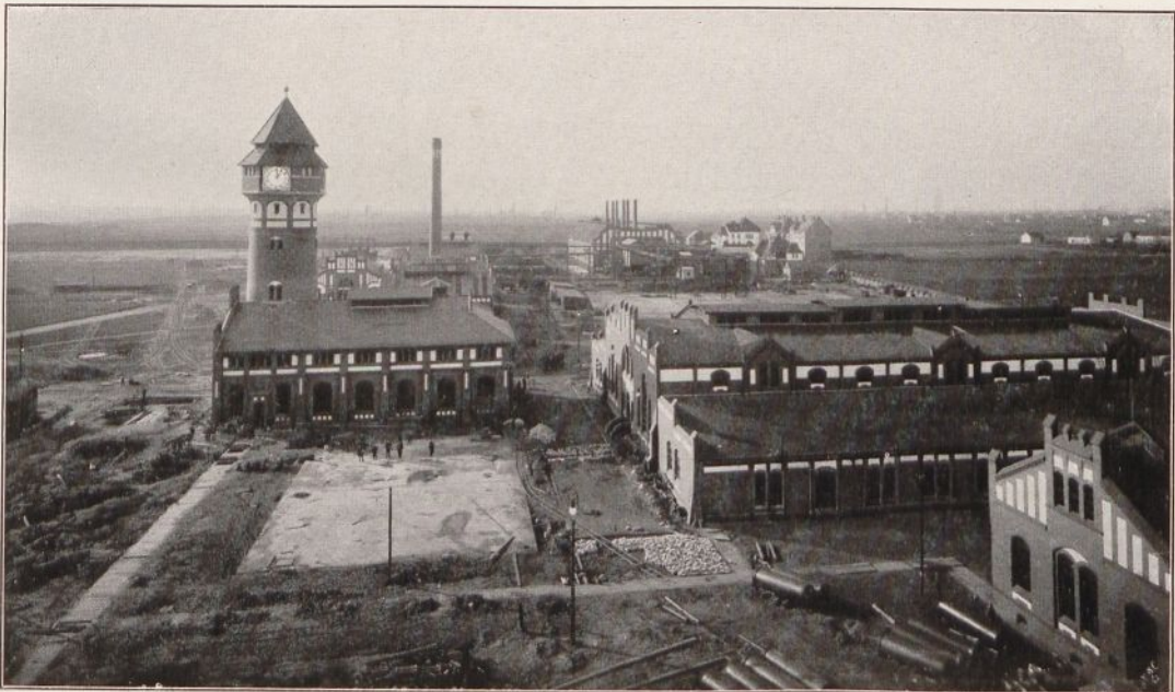
Blick vom Gasbehälter mit der Ammoniakfabrik in der Mitte.
