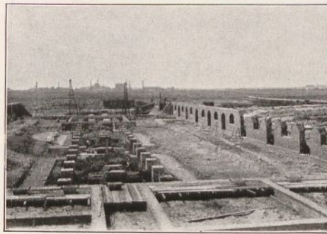
Beginn der Fundamente.
