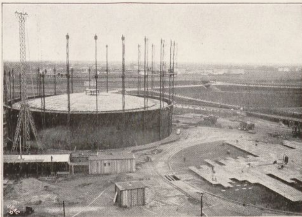
Boden für Behälter II am 3. April 1906.
