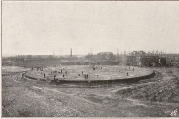
Behälter I am 30. September 1905.
