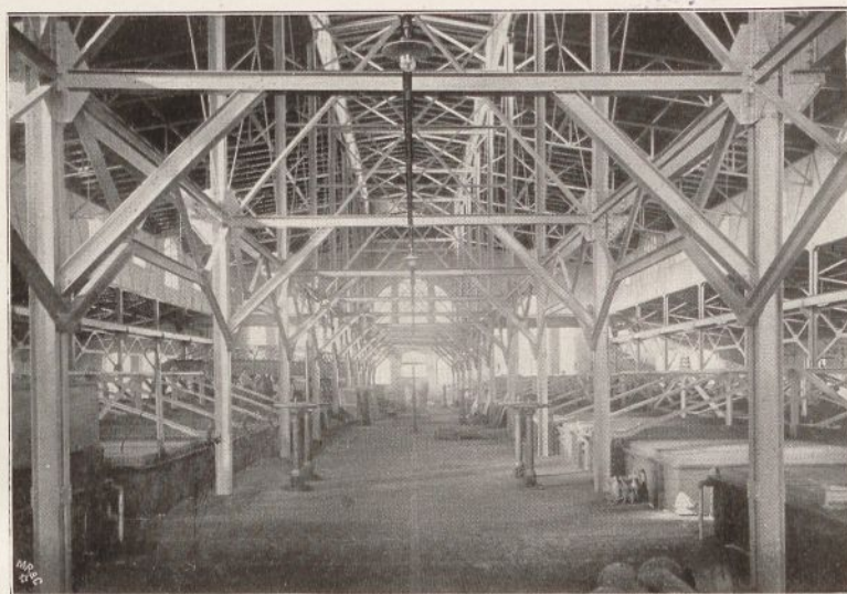
Blick auf die Reinigerkästen.
