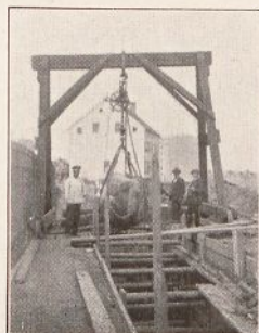
Herausheben eines 90 Ztr. schweren Rindlings aus der Baugrube.
