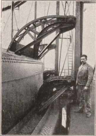
Führungsrollen der drei Teleskope.
