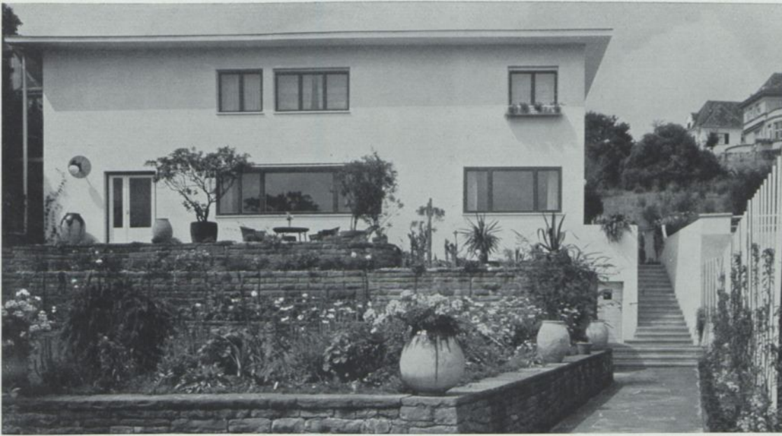
Die Terrassen an der Südostecke sind aus rotem Sandstein gemauert, der der Erdfarbe ähnelt
