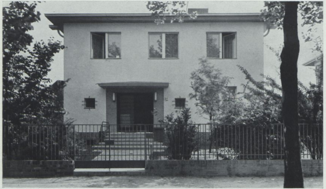
Die nach Norden gelegene Eingangsseite
