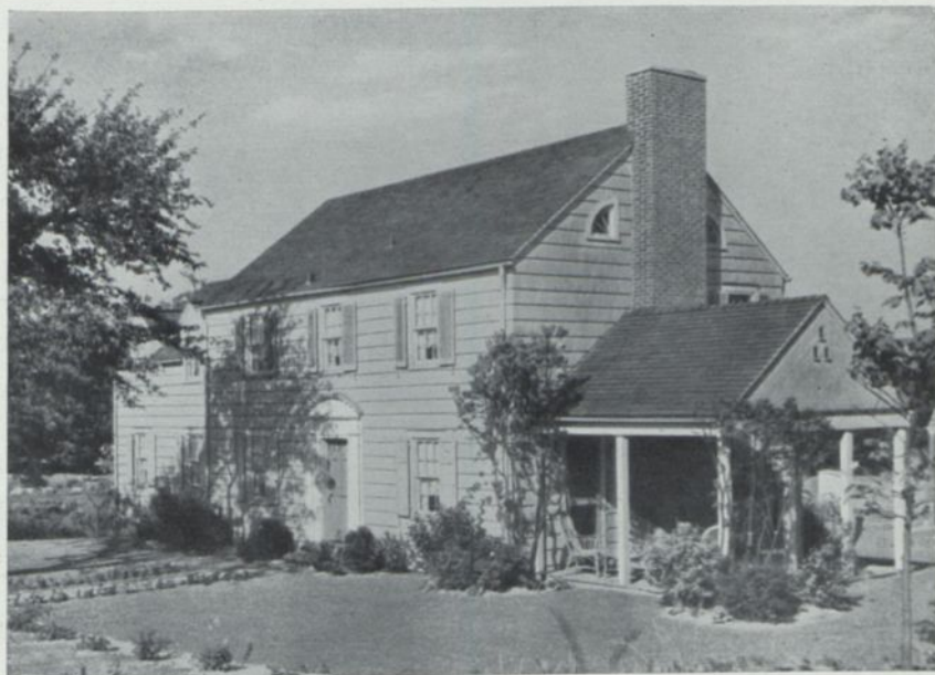
Oben: Die Amerikaner verstehen auch größeren Einfamilienhäusern ein schlichtes Äußeres zu geben. Nur der Dachraum über dem Haupthaus ist genutzt, daher die verschiedene Giebelhöhe. Im Erdgeschoß: 1 Eingangshalle, 2 Wohnraum, 3 Speisezimmer, 4 Küche, 5 Mädchen.
