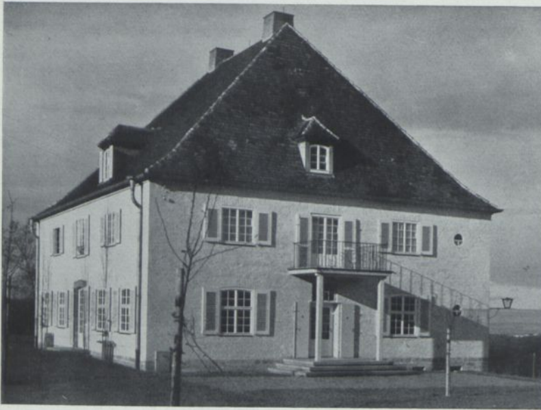
Haus eines Fabrikherrn mit Kindern. Ostansicht. Grundrißerläuterung zum Erdgeschoß: 2 Wohnzimmer, 3 Schreibzimmer der Dame, 4 Eßzimmer, 5 Kinderzimmer, 6/7 Anrichte und Küche. Im Obergeschoß Schlafräume und Frühstückszimmer
