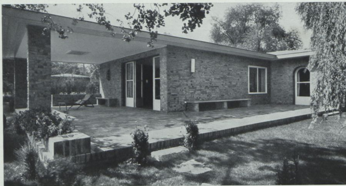
Ostansicht des Hauses N. von S. 53
