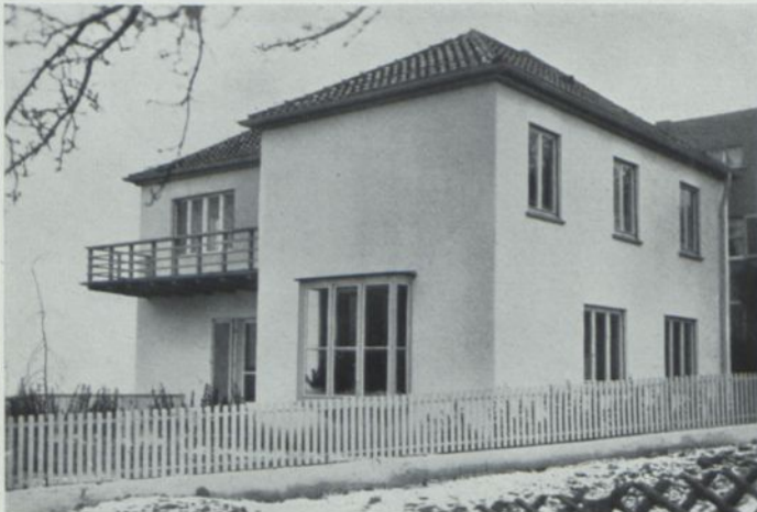
Ein spitzulaufendes Eckgrundstück am Steilhang hinderte den Architekten nicht an einer klaren Hausform. Die Küche kam hangseitig ins Untergeschoß. Der Holzbalkon liegt im Einsprung gegen Westen der Stadtaussicht zu
