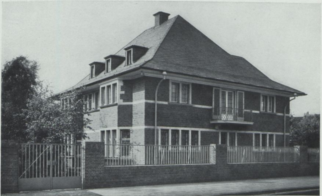
Haus S. in Düsseldorf, Ansicht von der Straße
