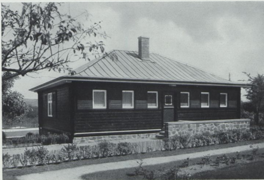
Straßenseite. Ein Sockel aus Bruchsteinmauerwerk isoliert das Holz von der Bodenfeuchte
