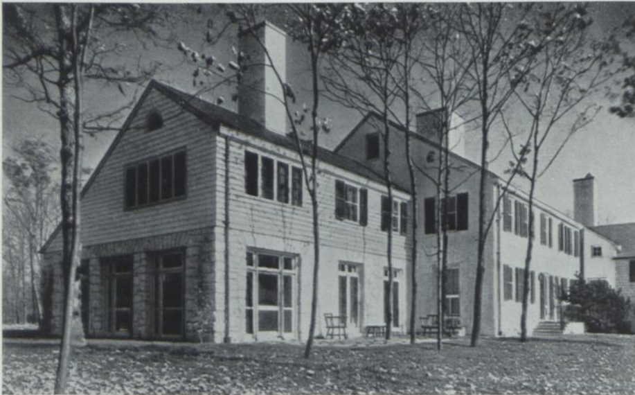
Ein größerer Landsitz mit Stallungen und Garage. Der eigentliche Wohnbau liegt, in Ost-West-Richtung verlaufend, am weitesten südlich, dahinter gestaffelt der Trakt mit den Wirtschaftsräumen und der Küche. Nach Norden streckt das Haus einen Quergiebel vor, der unten die Wagenhallen, oben die Dienerräume enthält
