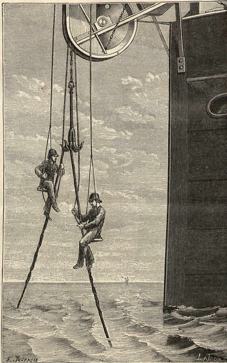
Festmachen des aus der Tiefe heraufgeholtens Kabels.
