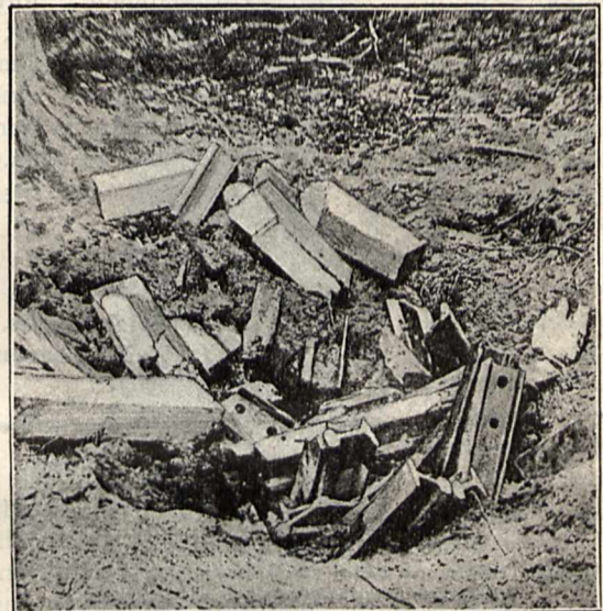
Sprengung einer doppelt gelegten Decke von Eisenbahnschienen durch eine mit 4,2 kg Schiesswoll-Kornpulver geladene 21 cm Granate. *)
