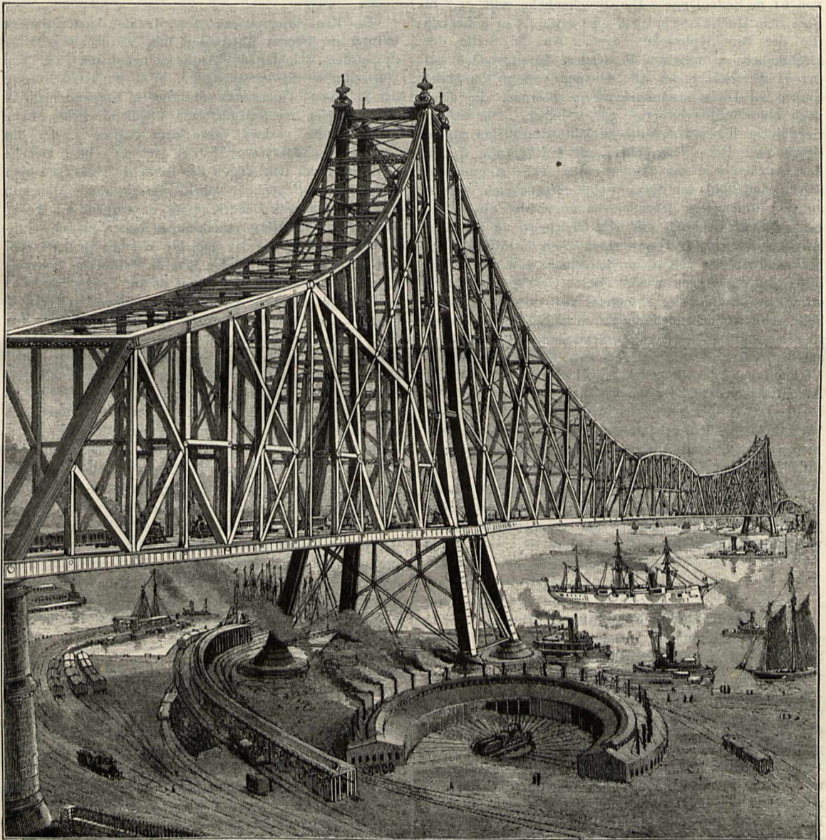
Die künftige Hudson-Brücke in New York.
