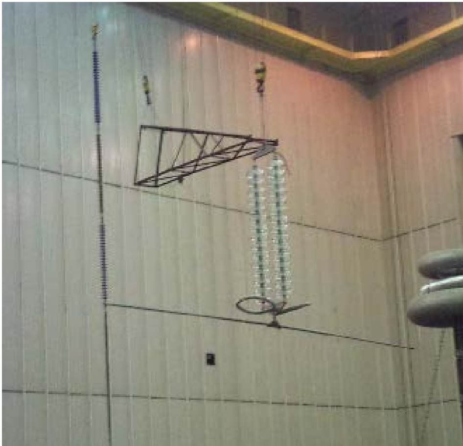
Rys. 43. Podwójny łańcuch przelotowy izolatorów szklanych kołpakowych
