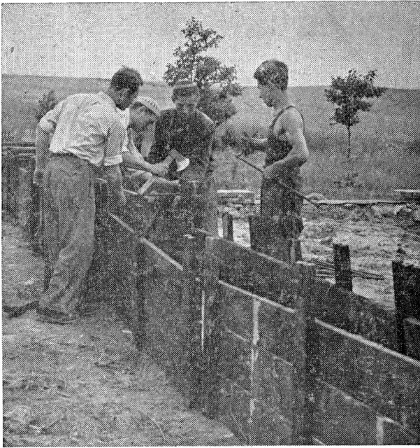
Gospodarstwo PGR Kolniszki — budowa stajni z gliny. Ustawianie form
