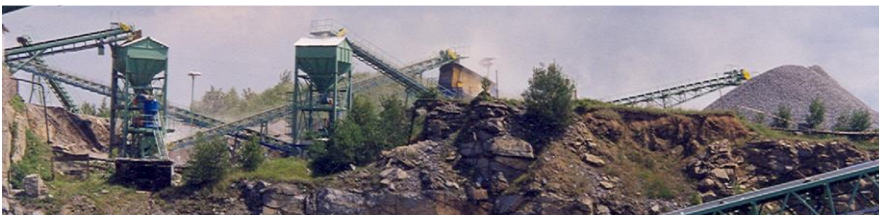
Rys. 6. Często w praktyce widok na sposób zabudowy maszyn
