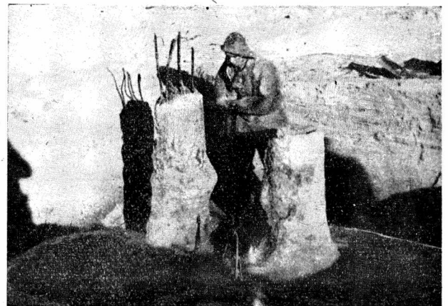
Rys. 8. Górna część odkopanych pali Wolsholza.
