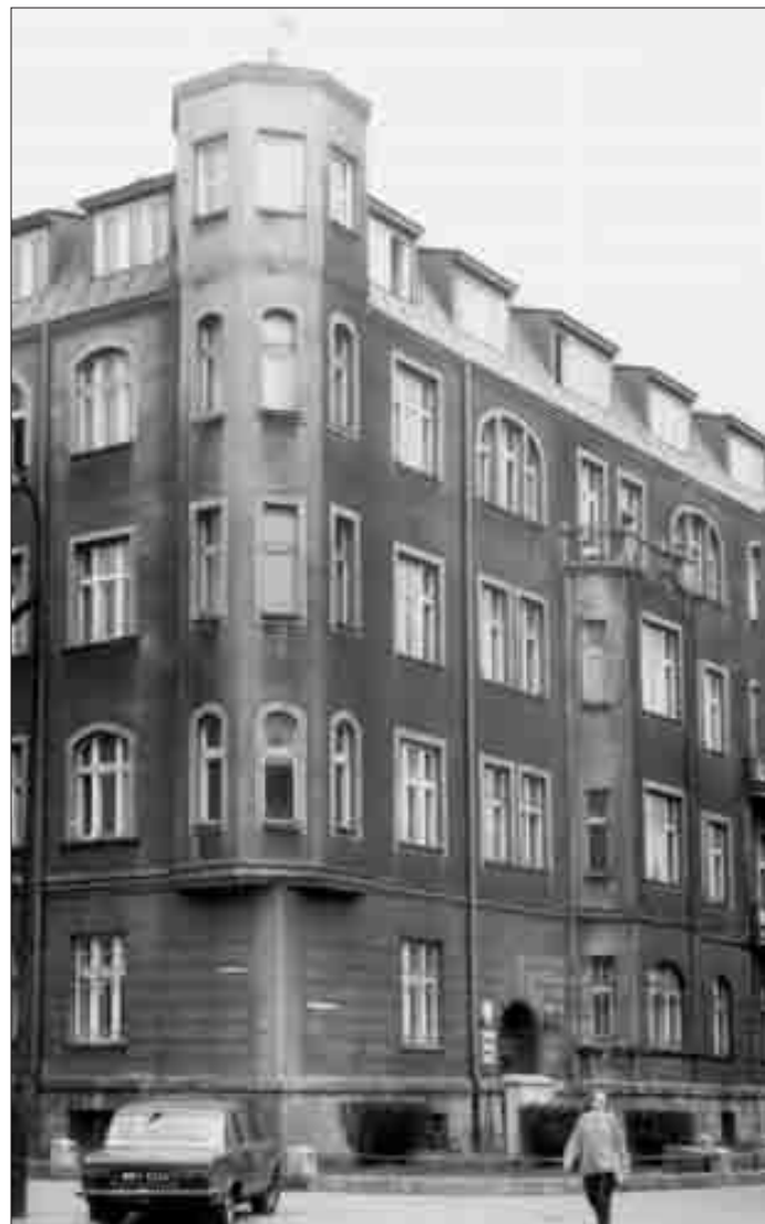
Budynek Wydziału przy ul. Marii Skłodowskiej-Curie 42 (do 1997 r.)
