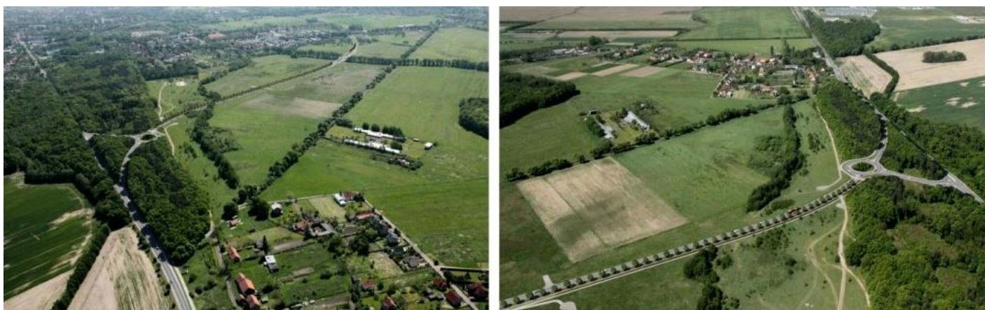
Il. 44. Budowa połączenia portu lotniczego ze stadionem piłkarskim - projektowana trasa na odcinku od ul. Średzkiej do ul. Miodowej. Widok w kierunku wschodnim i zachodnim. Źródło: http://www.mmwroclaw.pl/450475/2013/6/6/obwodnica-lesnicy-jest-decyzja-srodowiskowa-wizualizacje?category=news .
