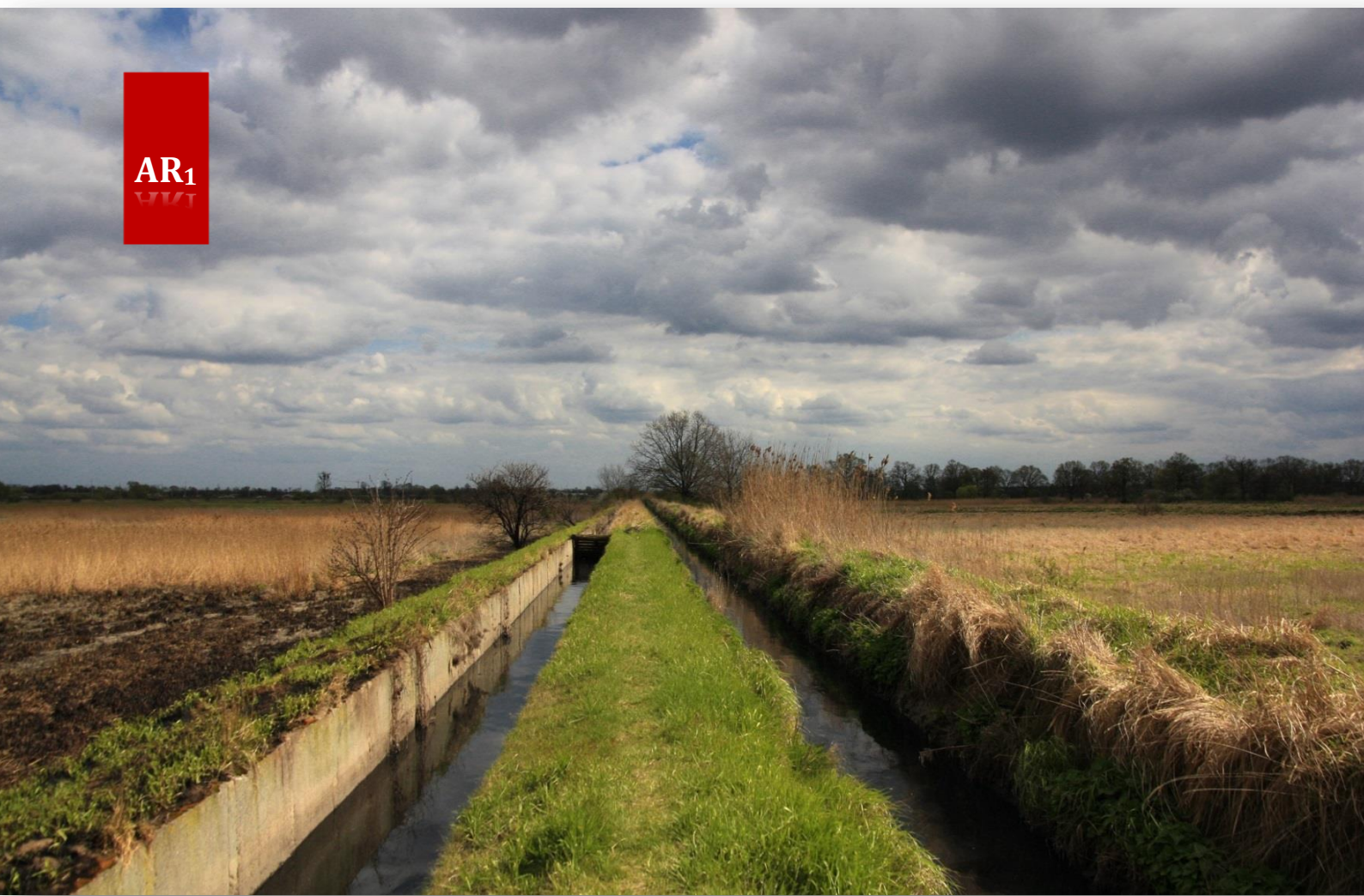
II. 87. Osobowickie pola irygacyjne , krajobraz reliktowy AR 1 . Ortogonalna kanwa kompozycyjna krajobrazu pól, współtworzona przez sieć klinkierowych kanałów rozprowadzających ścieki na kwatery. Fot. autor, wiosna 2011.
