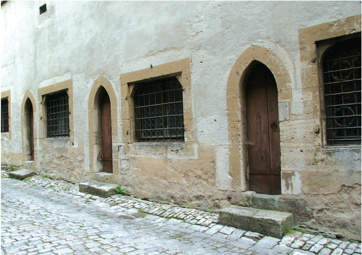
Il. 6. Ostrołuczne formy nadproży w ciągu kramów w Rothenburg ob Der Tauber we Frankonii (fot. M. Chorowska)
