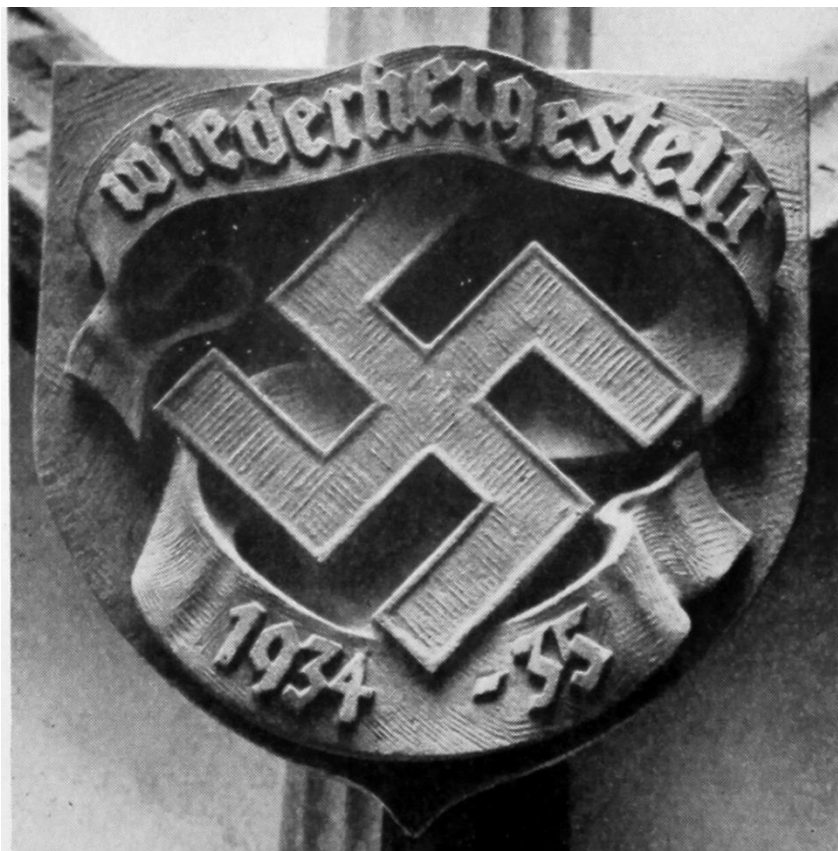
II. 43. Wrocław – ratusz. Nowy zwornik na zrekonstruowanym sklepieniu nad nawą południową refektarza. R. Stein, Die Wiederherstellungsarbeiten im Breslauer Rathaus... , il. 182.
