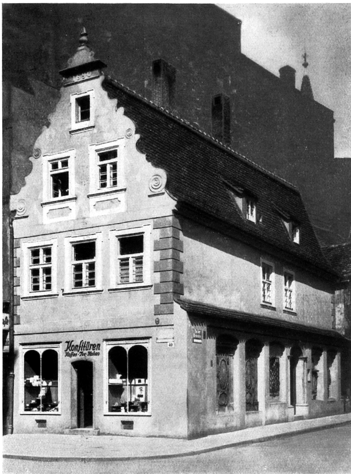
Il. 19. Wrocław. Kamienica przy ul. św. Mikołaja 40 po pracach konserwatorskich. Jahresbericht des Provinzialkonservators der Kunstdenkmäler Niederschlesiens für die Jahre 1935, 1936, 1937... , il. 107.
