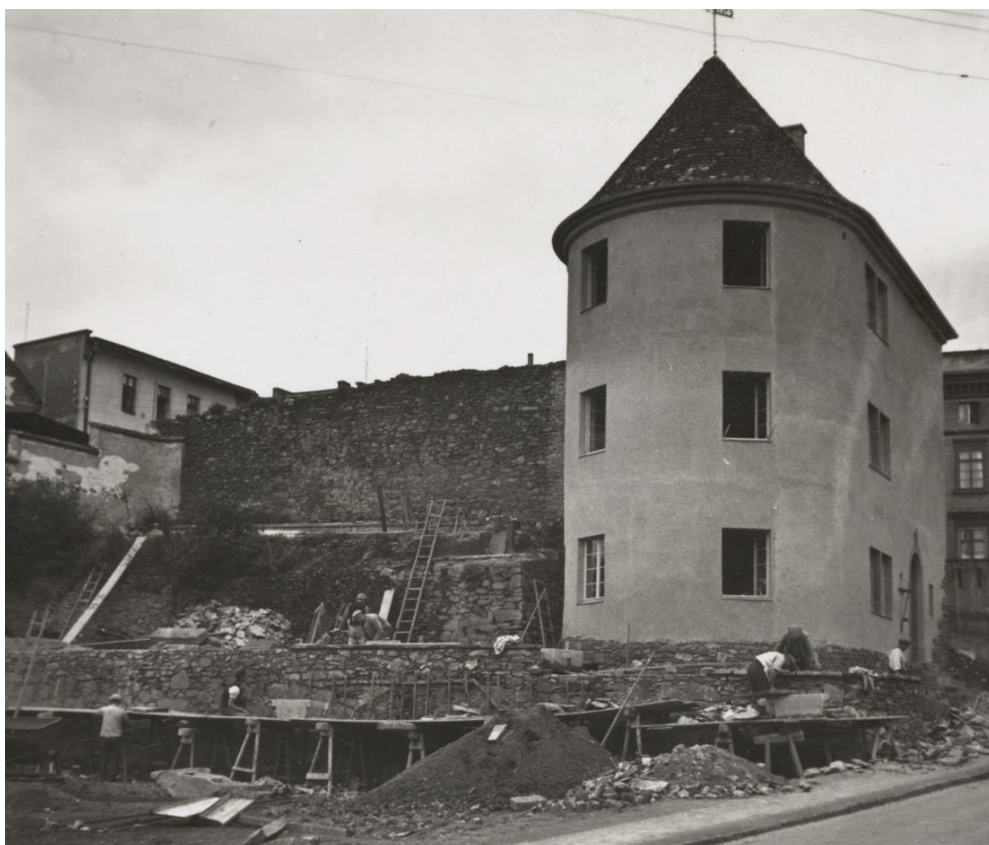
II. 73. Niemcza. Budowa schroniska młodzieżowego w miejscu Bramy Górnej, połączona z rekonstrukcją murów obronnych. Instytut Herdera NBA sygn. 236470.
