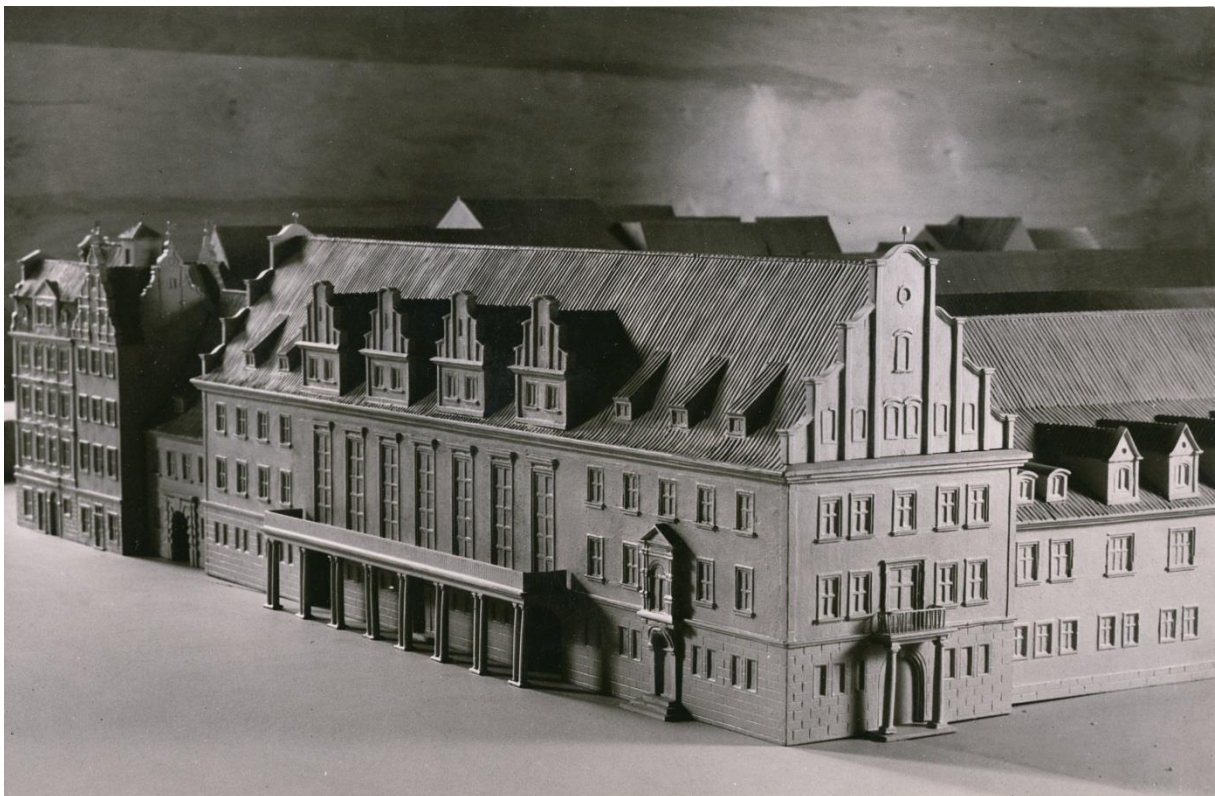
II. 15. Wrocław. Model sanacji zabudowy śródmiejowej, opracowany w 1940 roku wg koncepcji Rudolfa Steina. Muzeum Miejskie Wrocławia, Dział Ikonografii
