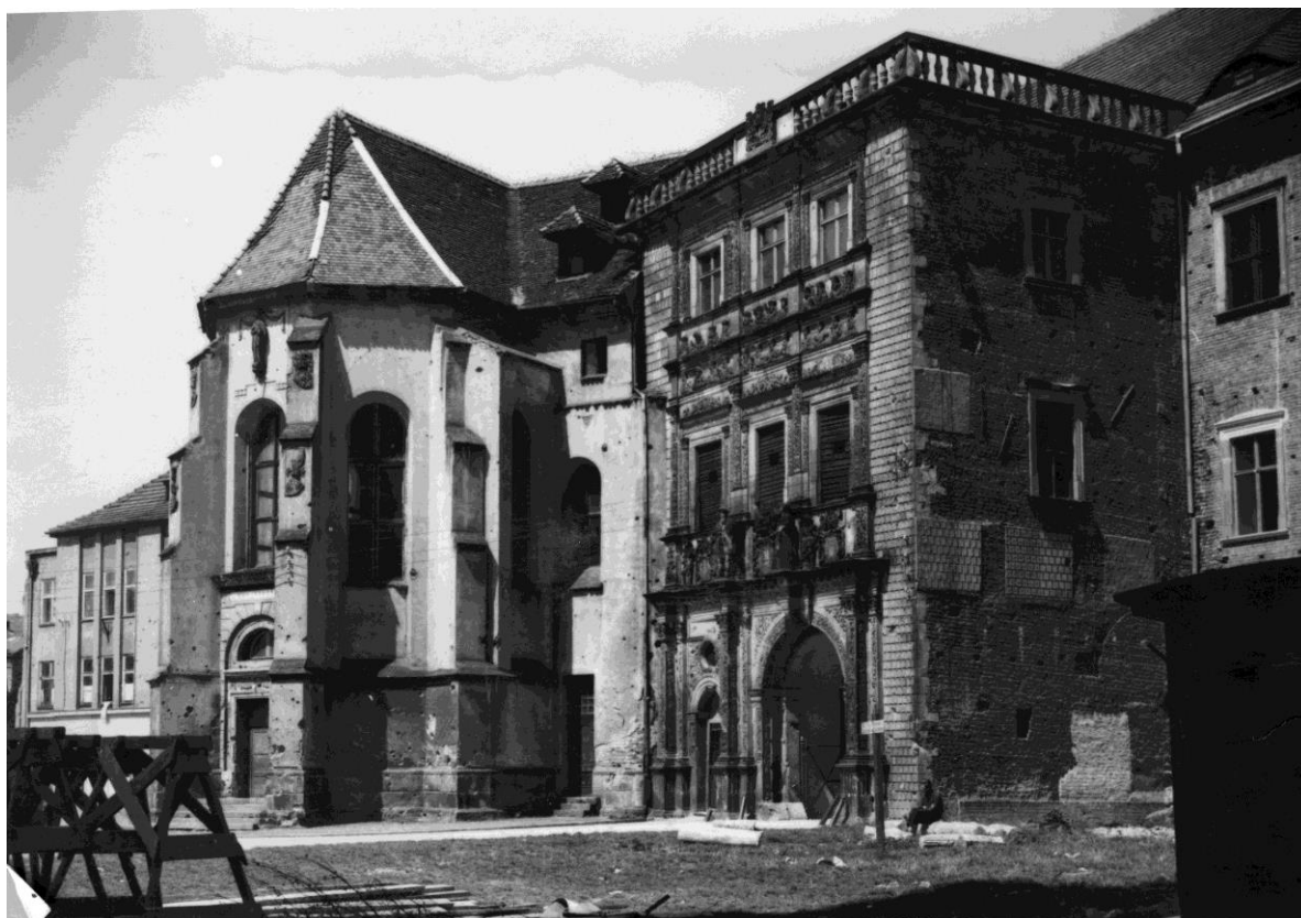
II. 150. Brzeg. Zamek, budynek bramy z nową balustradą nad gzymsem koronującym, fot. 1959, K. Gawinowska, w M. Zlat, Brzeg. Zamek. Dokumentacja prac konserwatorskich , PP PKZ Wrocław.
