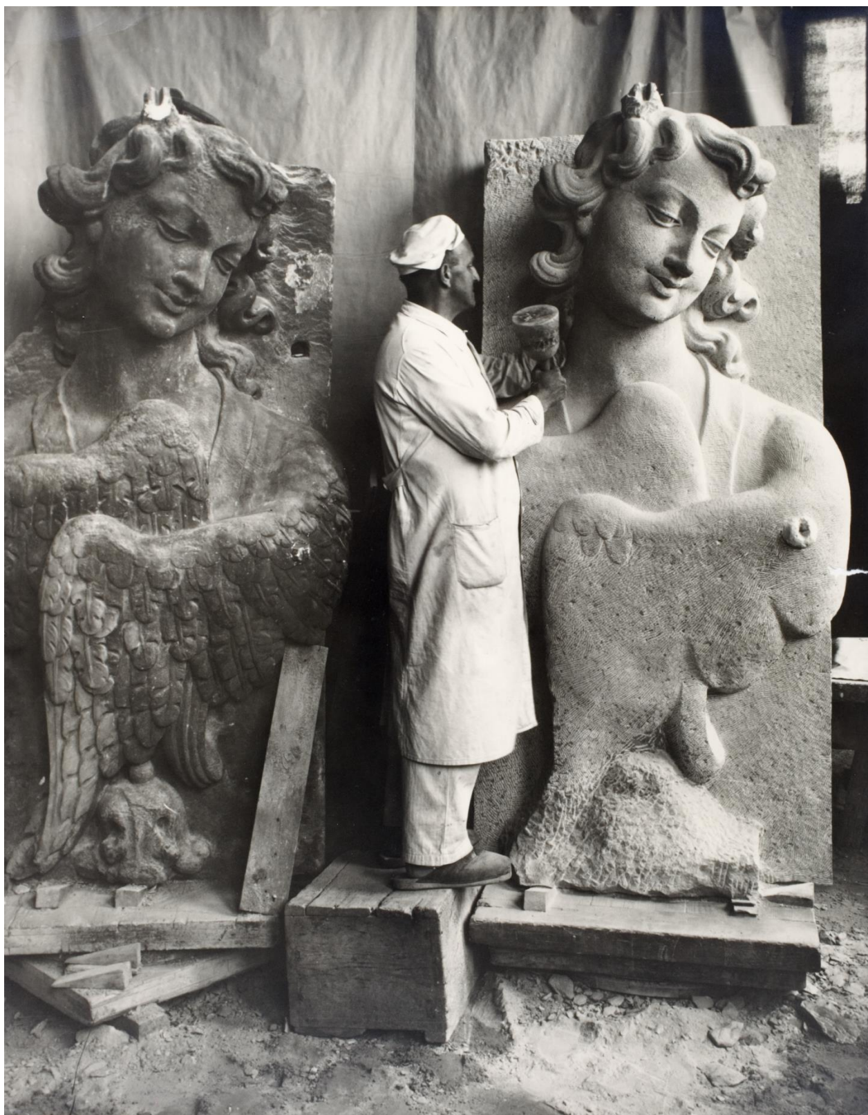
II. 118. Krzeszów, kościół klasztorny pw. Wniebowzięcia NMP, odkuwanie kopii jednego z serafinów ze zwieńczenia wieży. Instytut Herdera NBA sygn. 131136.
