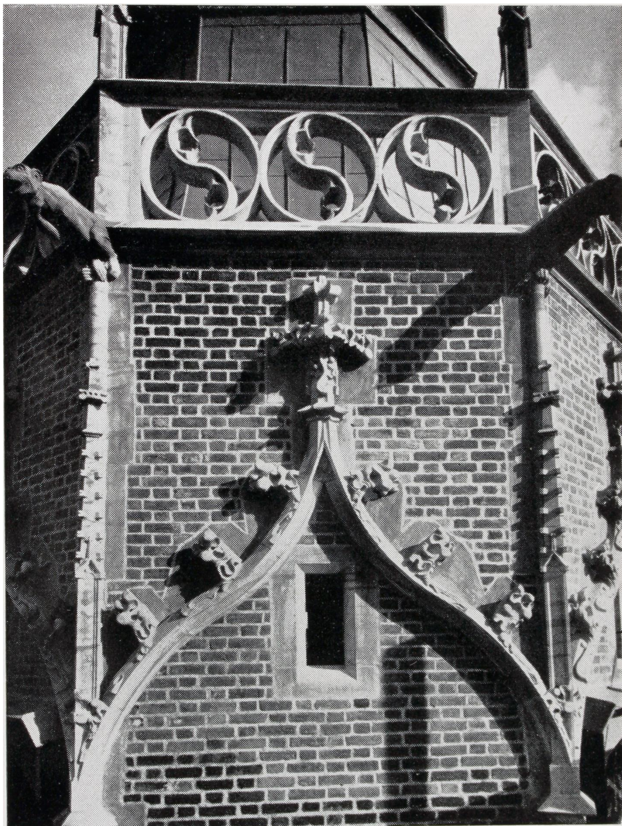
Il. 55. Nysa – wieża ratusza. Stan kamiennej dekoracji elewacji po pracach konserwatorskich. H. Fiebiger, Die Wiederherstellung des Rathausturmes zu Neisse... , il. 56.
