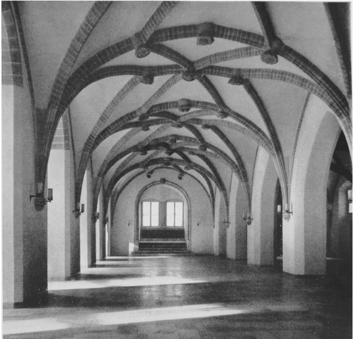
Il. 38. Wrocław - ratusz. Środkowa nawa refektarza, stan po renowacji, widoczne odsłonięte ceglane żebra sklepienia. R. Stein, Die Wiederherstellungsarbeiten im Breslauer Rathaus... , il. 143.
