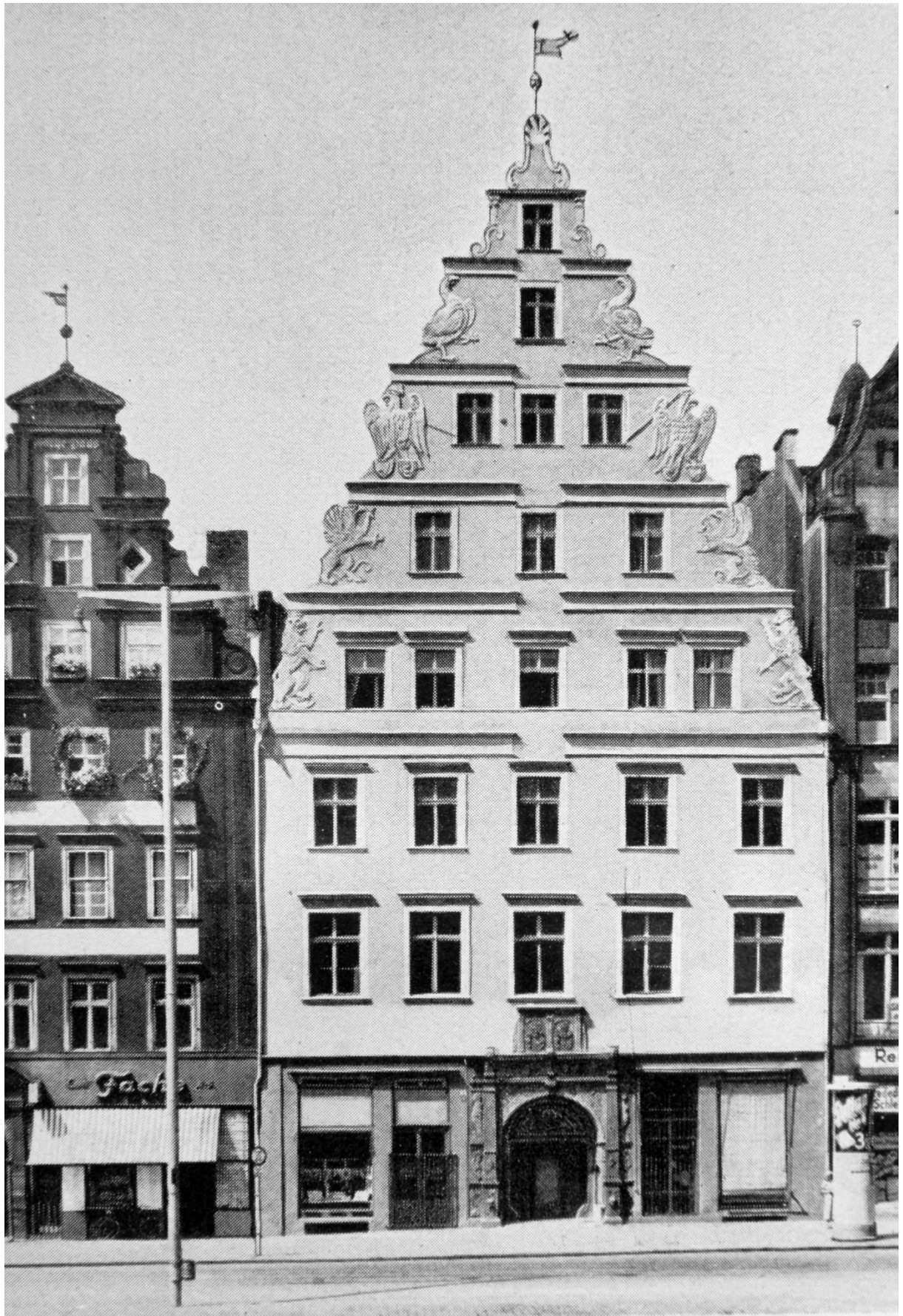
II. 21. Wrocław. Rynek 2, Dom pod Gryfami, stan po konserwacji w 1935 roku. R. Stein, Die Wiederherstellung des Greifenhauses zu Breslau , „Deutsche Kunst und Denkmalpflege”, Jg. 37: 1935, il. 240.
