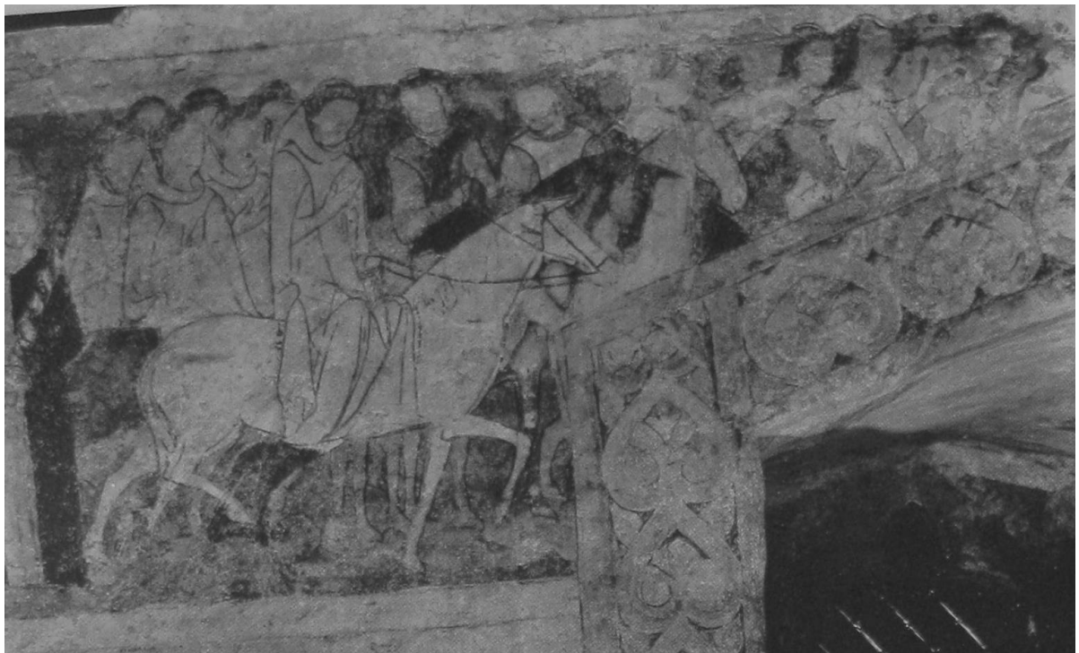
Il. 98. Siedlęcín. Książęca wieża mieszkalna, wnętrze, polichromia, stan po konserwacji. R. Probst, Zur Instandsetzung des Wohnturmes... , il. 90.
