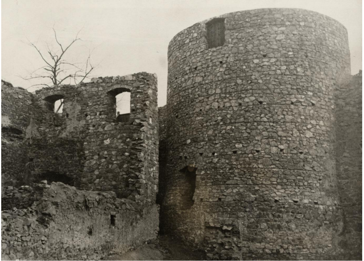
Il. 82. Zamek Cisy. Wieża po pracach renowacyjnych i częściowej rekonstrukcji zwieńczenia. Instytutu Herdera NBA sygn. 78184.
