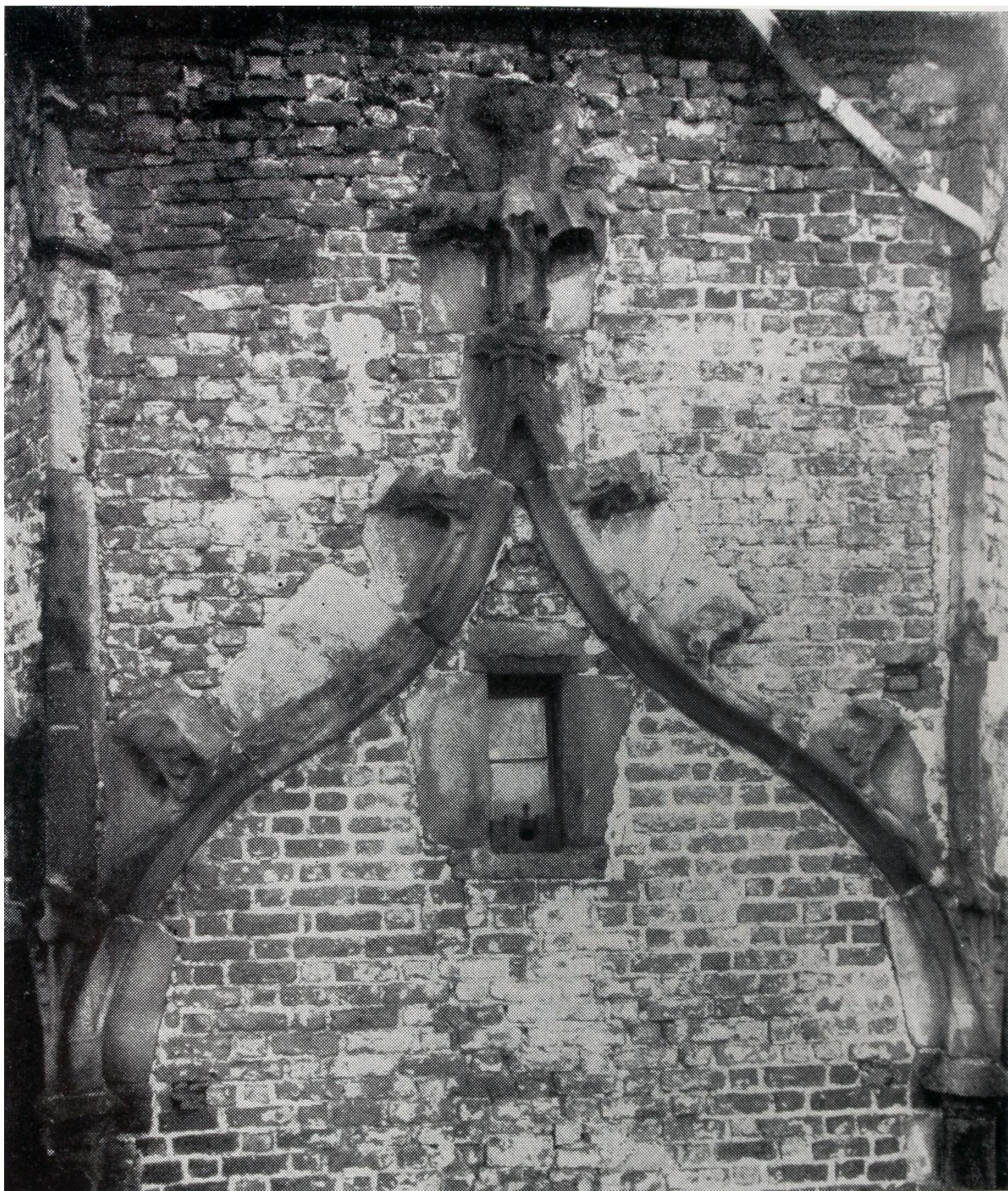
Il. 54. Nysa – wieża ratusza. Stan kamiennej dekoracji elewacji przed pracami konserwatorskimi. H. Fiebigger, Die Wiederherstellung des Rathausturmes zu Neisse... , il. 56.
