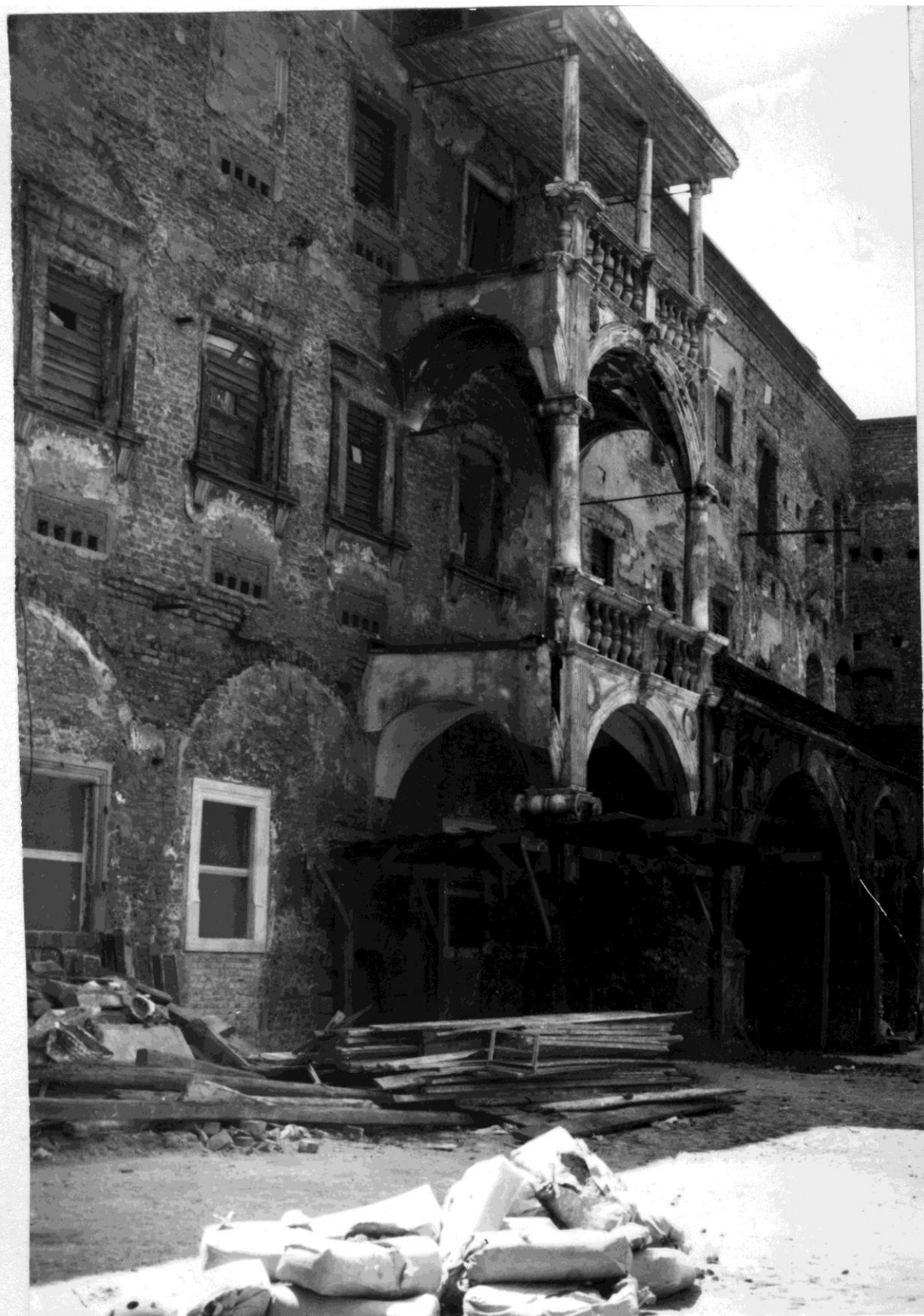
II. 152. Brzeg. Zamek, dziedziniec z wykonaną ok. 1940 roku makietą w skali 1:1 krużganków przewidzianych do rekonstrukcji, fot. 1959, K. Gawinowska, w M. Zlat, Brzeg. Zamek. Dokumentacja prac konserwatorskich , PP PKZ Wrocław.
