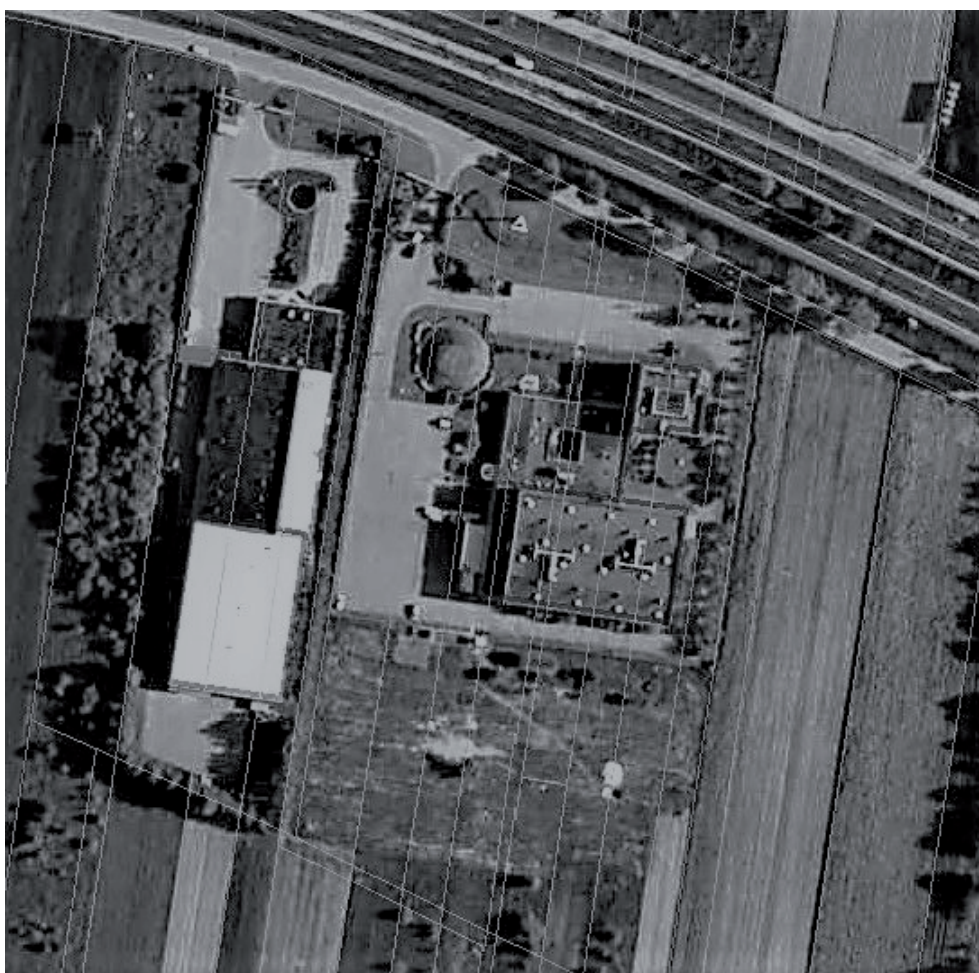
Rys. 4. Przykład zabudowy usługowo-produkcyjnej powstałej na kilku działkach ewidencyjnych w gminie Czosnów
