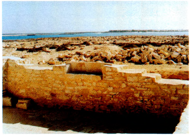
Ryc. 6. Dom H9, pomieszczenie 14. Ściana z przygotowanym łóżem niszy przed anastylozą. Stan z 1998 r. (fot. Rafał Czerner)
