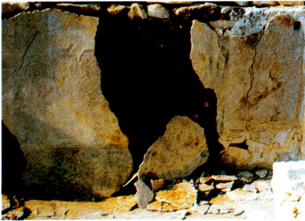
Ryc. 5. Dom H9, pomieszczenie 14. Lico ściany południowej ze zdewastowanymi relikami malarstwa ściennego. Stan z 1988 r. (fot. W.A. Daszewski)
