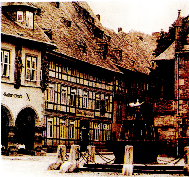
Ryc. 21. Rozwiązanie konstrukcji szachulcowo-ryglowej; dom w Goslar (Niemcy)
